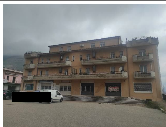
Particolare facciata del fabbricato dalla strada pubblica
