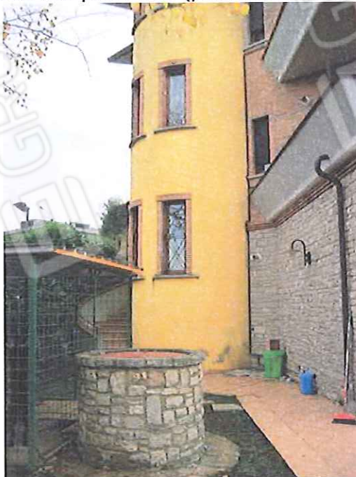
prospetto (particolare pozzo e rampa accesso al P.T.)
