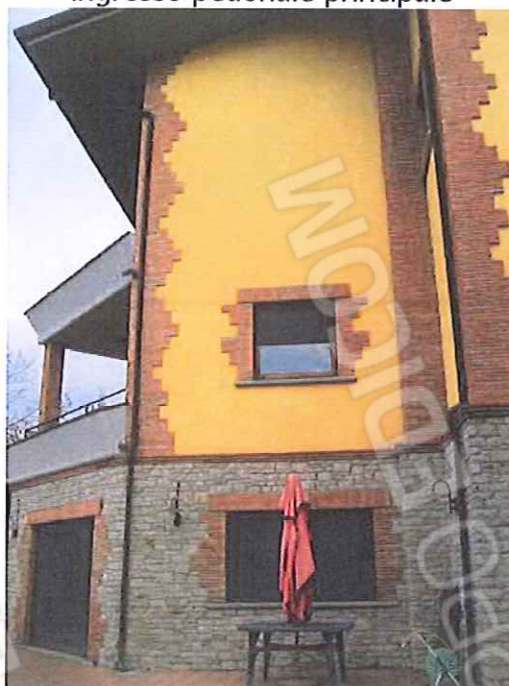
ingresso tavernetta piano seminterrato
