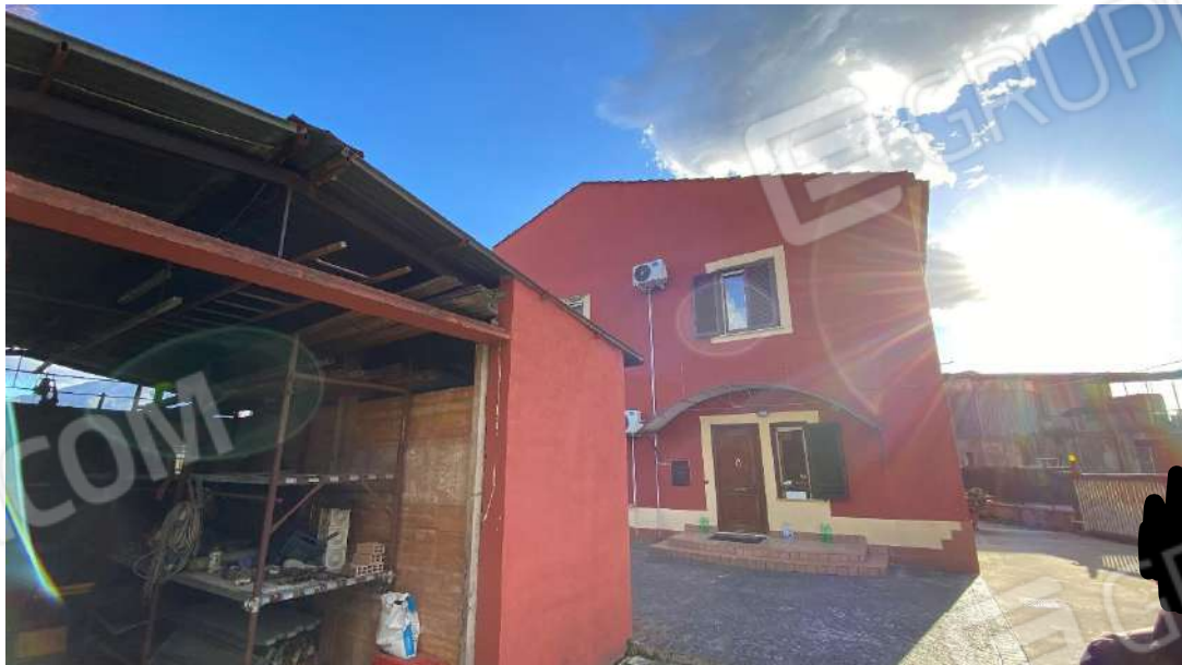
Foto n. 6 deposito part. 913 e ingresso part. 404
