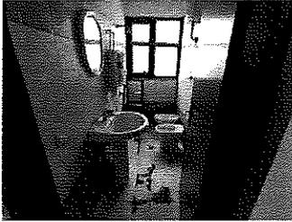
pavimentazione realizzato con piastrelle ceramiche posate a colla su massetto di sabbia e cemento, suggellatura dei giunti con fuga in cemento di colore chiaro, spessore cm. 0,3;
