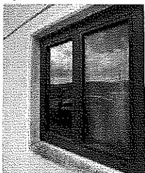
Infissi in vetro camera con ante a battente e telaio in Alluminio;
