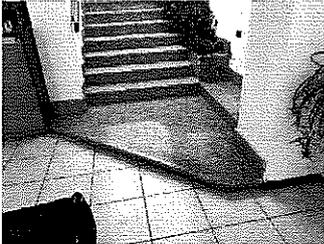
Al piano terra e Primo della palazzina uffici : pavimento in gres porcellanato formato cm. 33x33, posato a colla su massetto di sabbia e cemento suggellatura dei giunti con fuga in cemento di colore grigio, spessore cm. 0,5;
