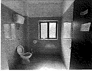
rivestimento realizzato con piastrelle ceramiche posato fino all'altezza di m. 2,20, suggellatura con fuga in cemento di colore chiaro, spessore cm. 0,3;
