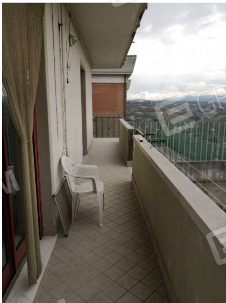
Fotogramma 08 – Unità immobiliare al P.T. – F. 29 p.IIa 482 sub 2 – Balcone
