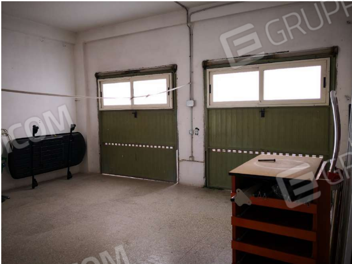
Fotogramma 16 – Unità immobiliare al P.Semint. – F. 29 p.Ila 482 sub 8 – Garage
