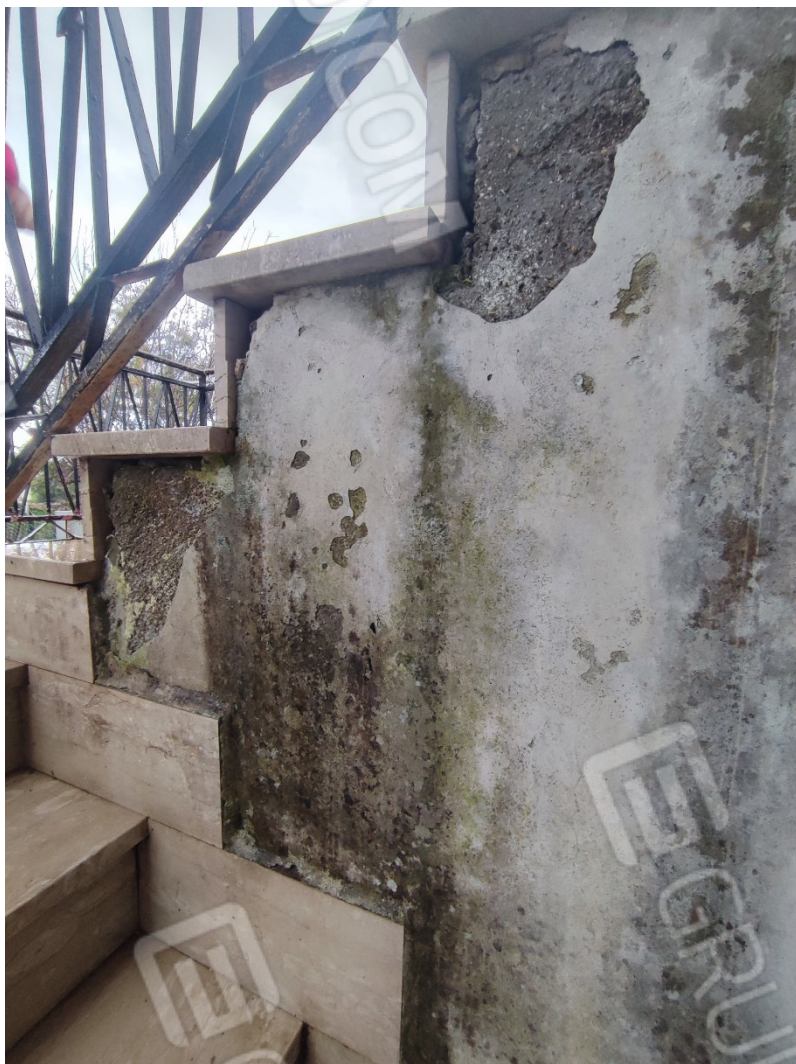
Piano Terra – Scala di accesso al Piano Primo
