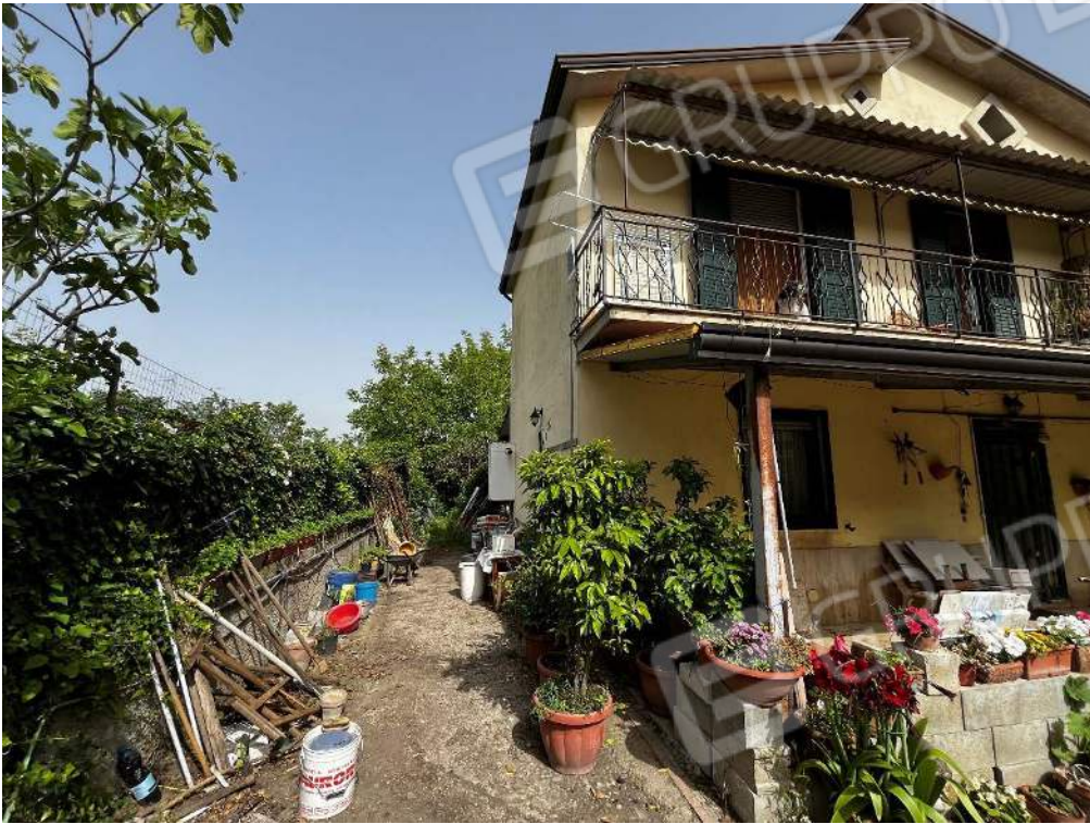
Foto n. 5: accesso lastricato al lato posteriore
