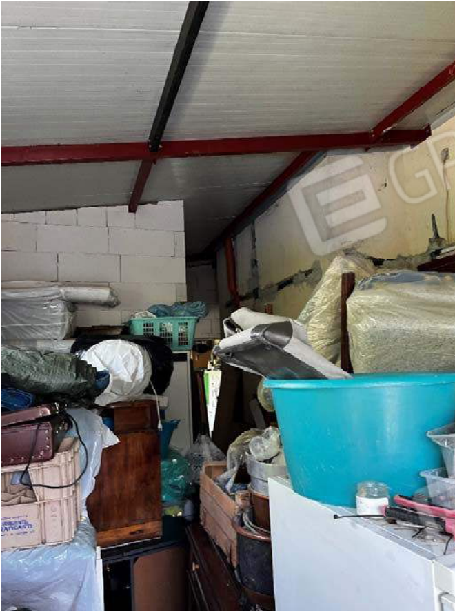
Foto 17: interno dei vani deposito
