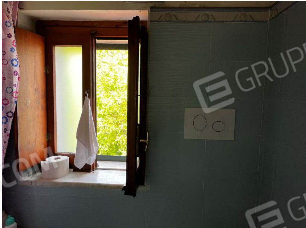
Foto n. 16: vano w.c. in corrispondenza del vano scala
