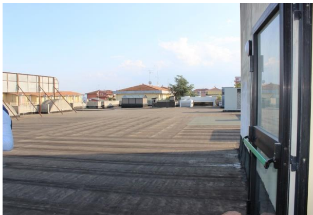
Corpo C – lastrico solare – vista dal lato NORD
