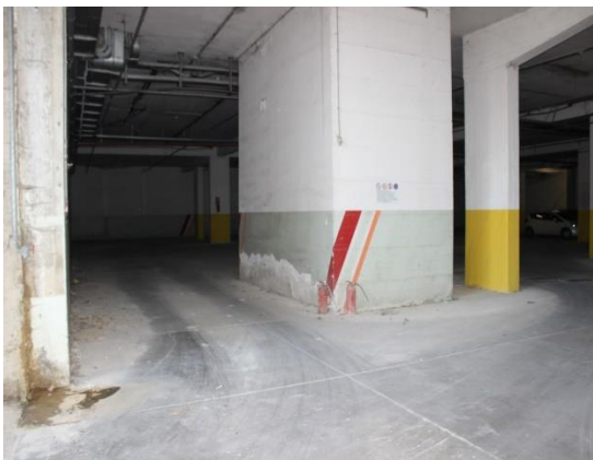
CORPO B – area parcheggio – piano s1 (1)
