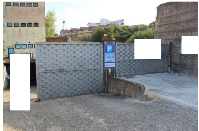
CORPO A – area parcheggio – piano T
