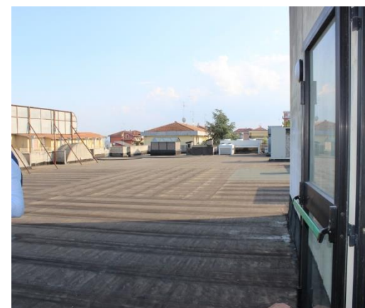
lastrico solare – piano 3
