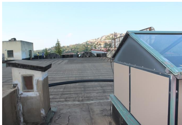
Corpo C – lastrico solare – vista dal lato SUD
