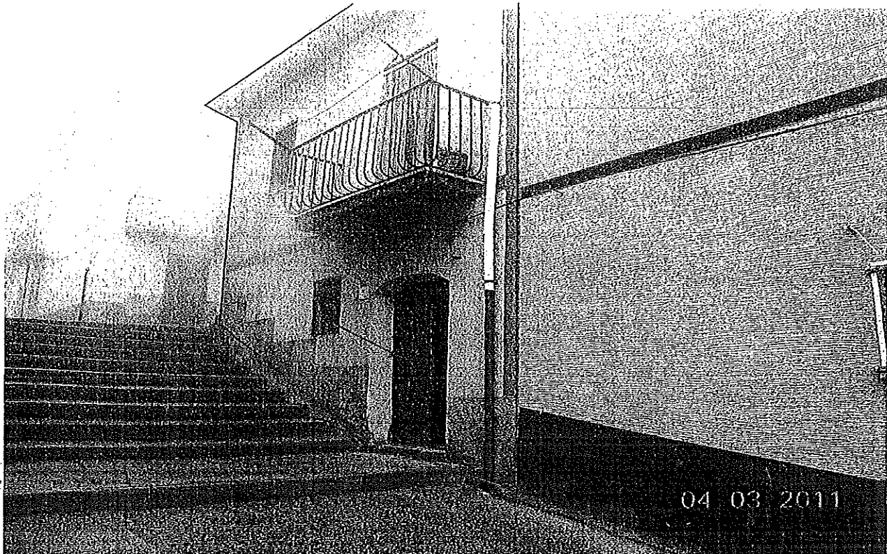
Foto 2 Prospetto laterale (E' rimarcato il fabbricato oggetto di pignoramento, la freccia indica l'accesso al piano Seminterrato).
