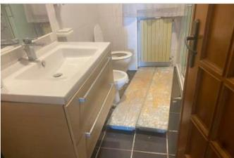
pavimentazione realizzato con piastrelle posate a colla su massetto di sabbia e cemento, suggellatura dei giunti con fuga in cemento di colore chiaro, spessore cm. 0,3;
