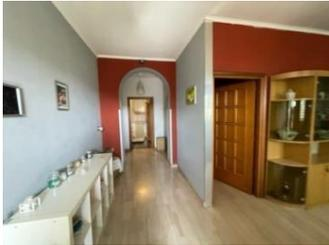
tramezzature realizzate con mattoni forati da cm 8 rifinite con intonaco liscio di cemento e tinteggiate con idropittura lavabile per interni.
