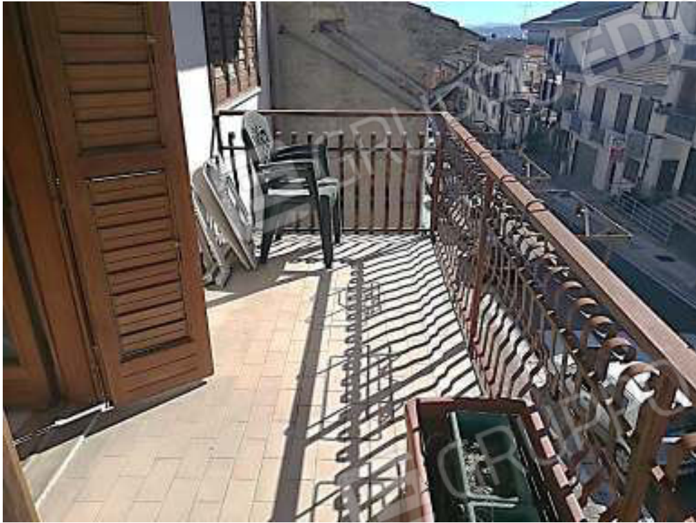
Foto 15: .. Balconi del Primo Piano, lato anteriore
