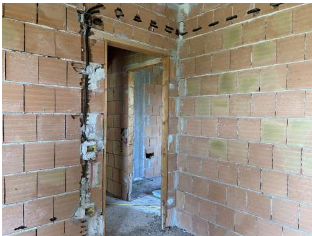
Fig.7 – Vista interni piano terra
