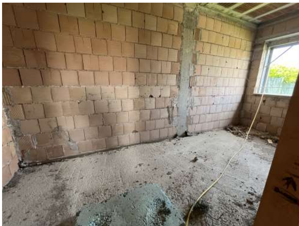
Fig.6 – Vista interni piano terra
