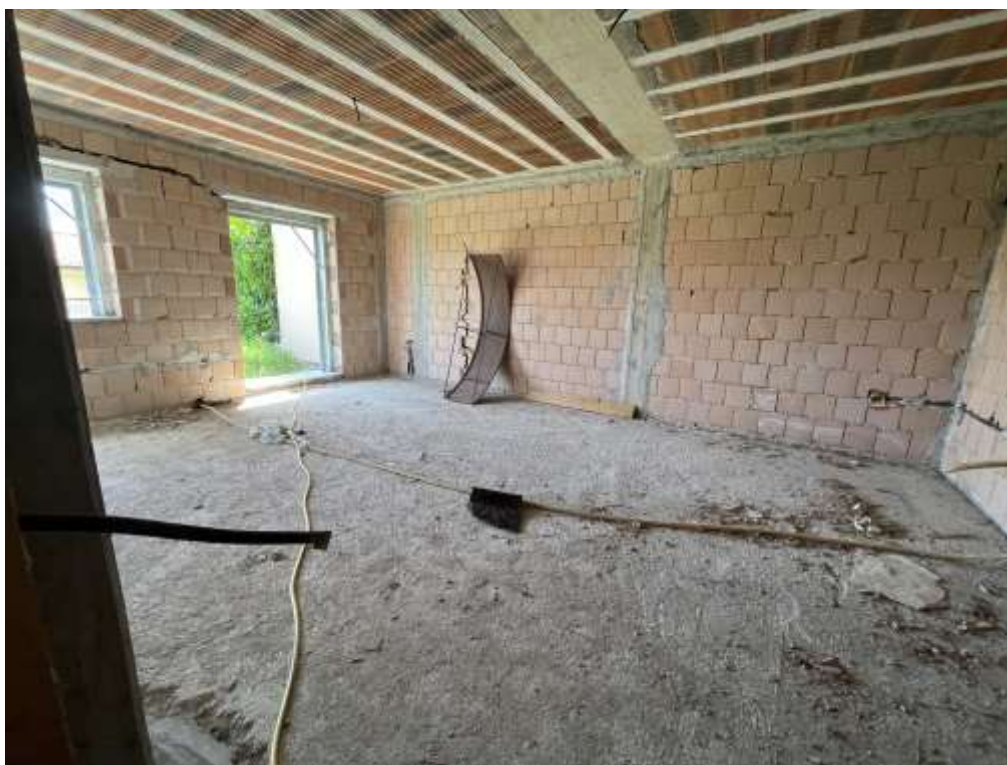
Fig.5 – Vista interni piano terra
