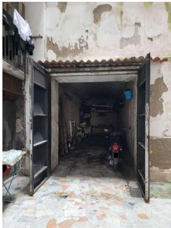
Vista cancello di ingresso al cespite
