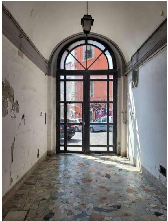
Vista vano androne per l'accesso allo stabile
