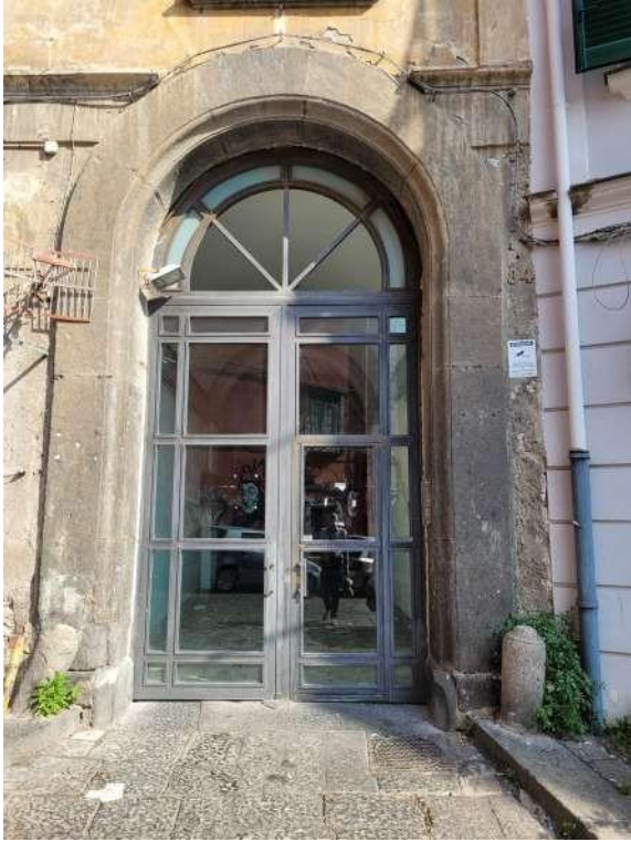
Vista portone/cancello di accesso allo stabile
