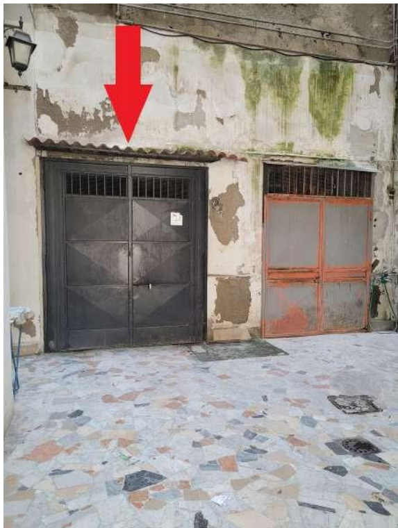
Vista cancello di ingresso al cespite
