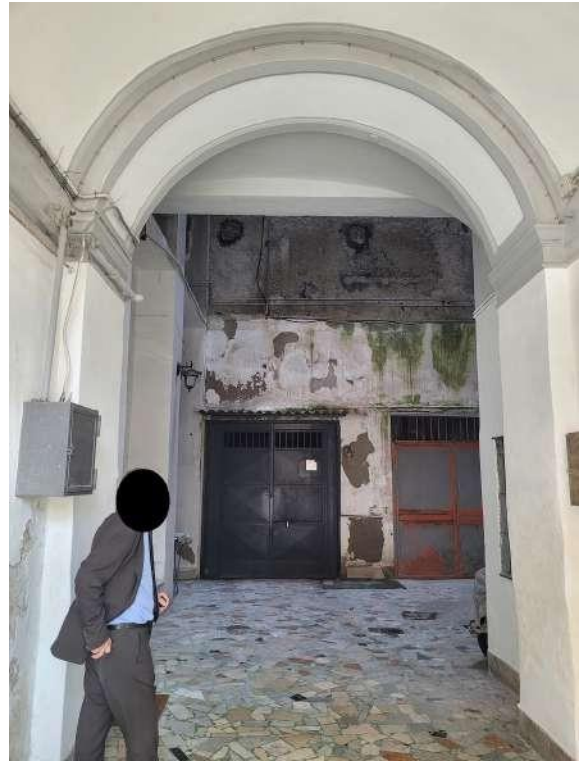
Vista vano androne per l'accesso allo stabile
