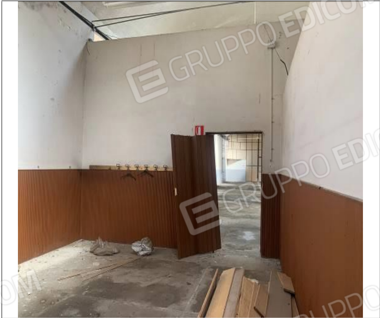
Immagine n.14 – Deposito
