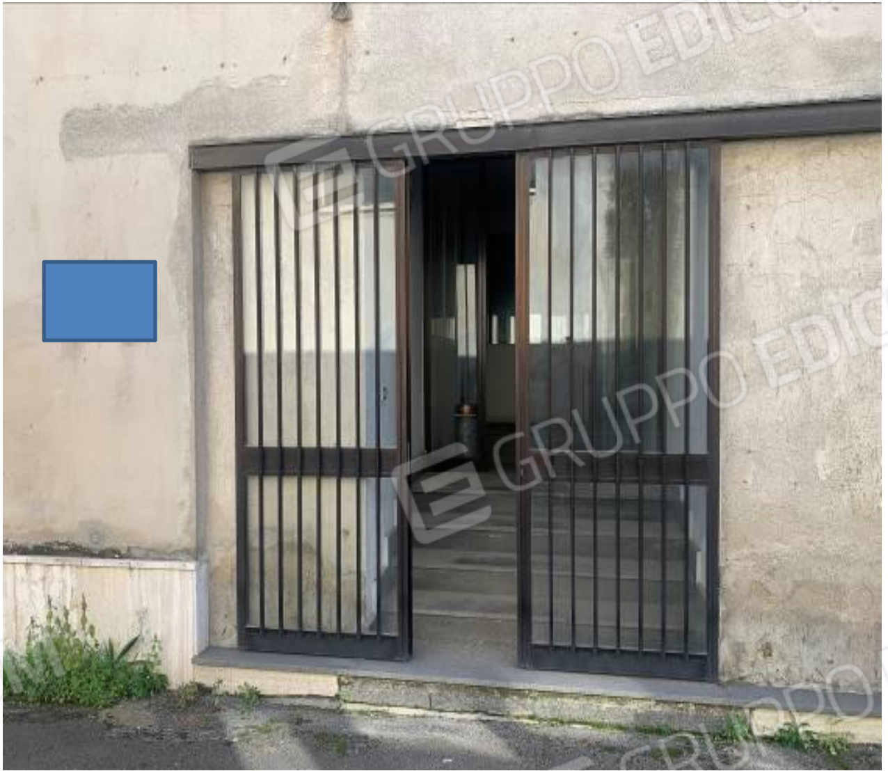
Immagine n. 1 – Ingresso uffici
