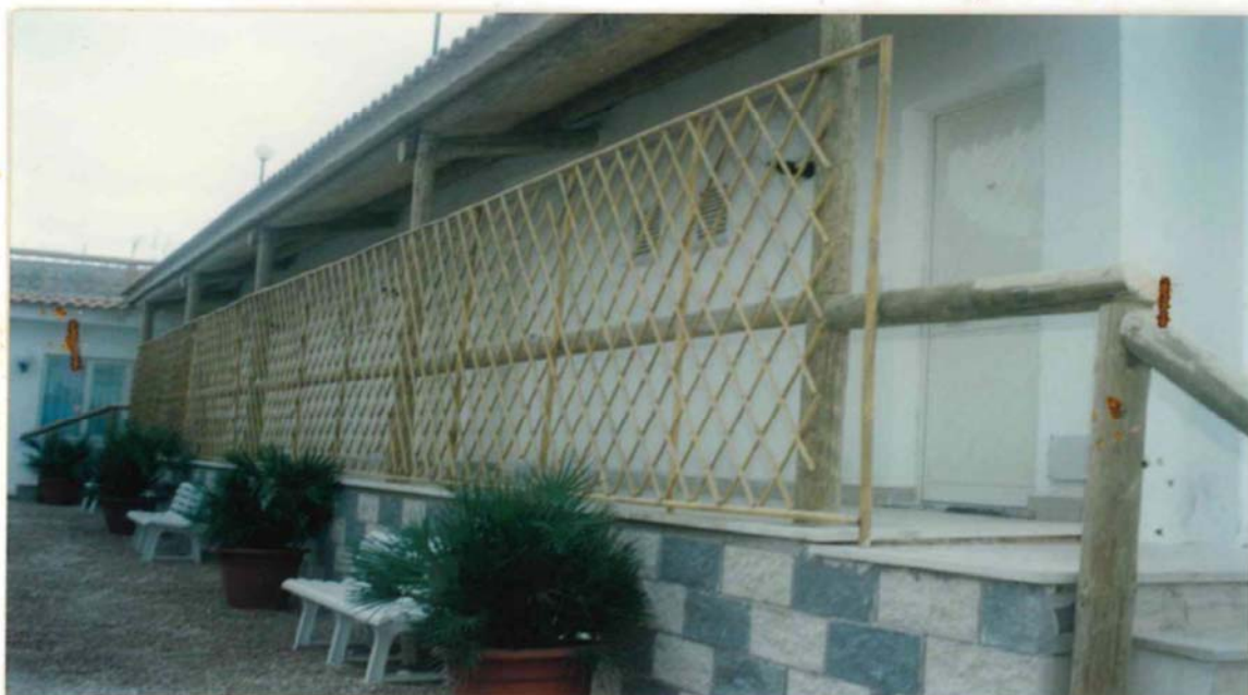
Figura 6: Foto allegate all'istanza di Condono prot. n. 5636 pratica n. 1666/95 del 01.03.1995. Le due foto, ritraggono la parte posteriore della sopraelevazione, in esse si può vedere come l'attuale corridoio del primo piano (oggi a servizio delle camere 343, 344, 345, 346 e 347) era costituito da un passetto.
