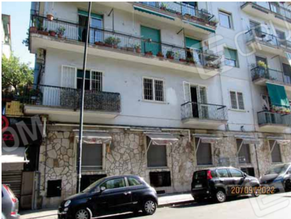
Fotografia 8 – Le chiusure d’ambito sono in muratura rivestite con intonaci ordinari e tinteggiate con pittura al quarzo, ad eccezione del prospetto al piano terra che affaccia sulla pubblica strada che risulta rivestito con lastre in marmo di media pezzatura posate ad “opus incerta”.
