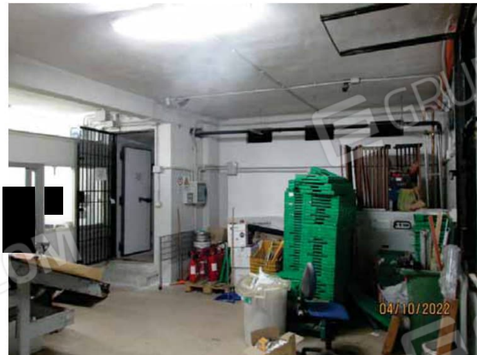
Fotografia 26 – Locale 2/a Sub 102: le pareti risultano interamente rivestite con piastrelle in ceramica smaltata, ad eccezione della parete di confine con il “Locale 2/b Sub 102” che risulta rivestita con intonaci ordinari a finitura liscia e tinteggiata con pittura lavabile.
