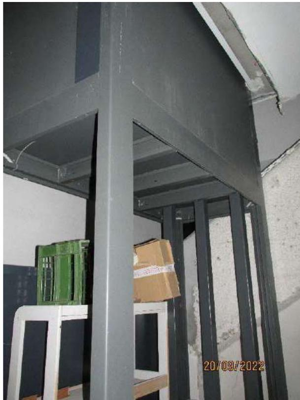
**Fotografia 17 – Nel disimpegno del piano interrato che conduce ai tre locali, è installata la struttura portante in ferro dell'ascensore condominiale, ma non è presente alcuna fermata dell'ascensore.**
