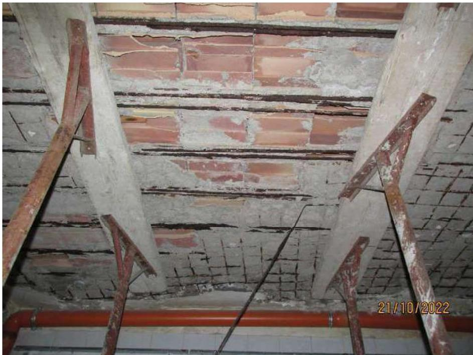
**Fotografia 37 – Locale 2/b Sub 102: Il locale versa in pessime condizioni di manutenzione, dovuto soprattutto all'avanzato stato di degrado dell'intradosso del solaio, il quale risulta puntellato per quasi la metà della sua superficie, con tavole di legno e puntelli telescopici in ferro.**
