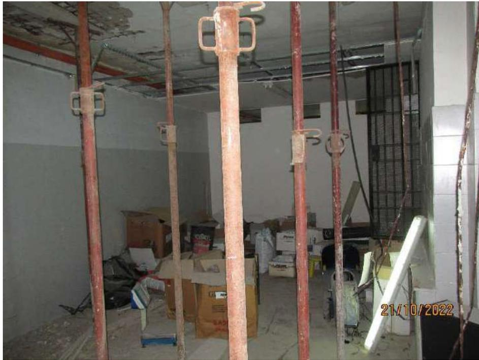
**Fotografia 38** – *Locale 2/b Sub 102*: Il solaio presenta serie carenze strutturali, la struttura portante del solaio costituita da travetti in c.a. gettati in opera, presenta la parte corticale ormai assente in più punti dovuta principalmente all'avanzato stato di ossidazione dei ferri di armatura che in alcuni tratti appaiono addirittura assenti. Tale stato di fatto, a giudizio dello scrivente, compromette l'agibilità e la praticabilità del locale.
