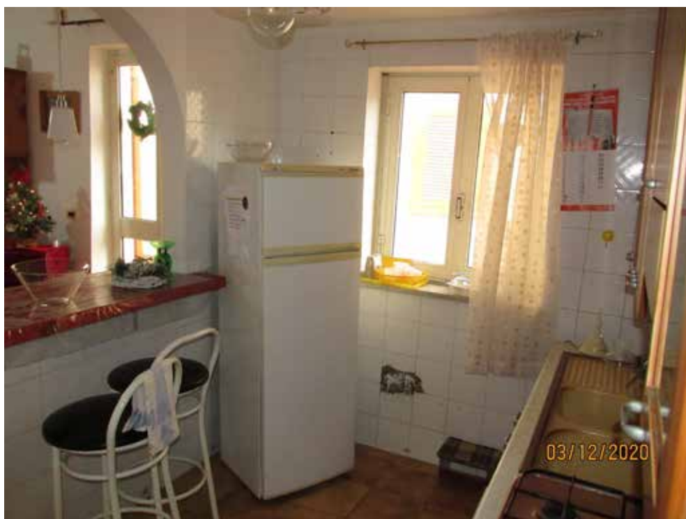
Fotografia 31 – Cucina: L'ambiente è dotato di una finestra esposta ad ovest con affaccio sul cortile comune, munita di un infisso in alluminio e vetro camera a due ante e protetta verso l'esterno da un serramento in ferro di tipo “persiana alla napoletana”.
