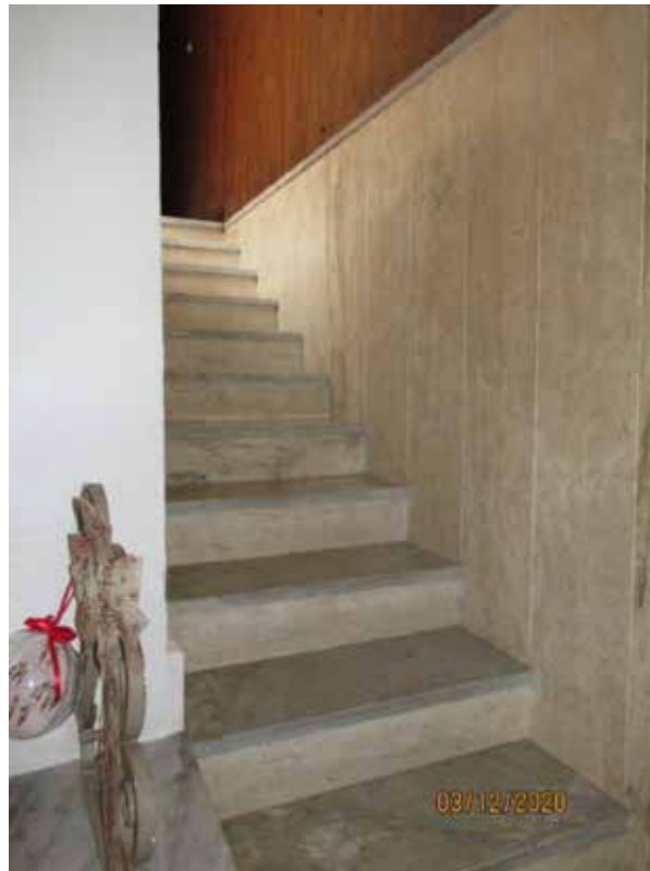
Fotografia 36 – Scala interna: La parete posta a destra di chi sale le scale è rivestita con lastre in marmo fino alla quota di calpestio del piano primo, la restante parte è rivestita con listelli in legno.
