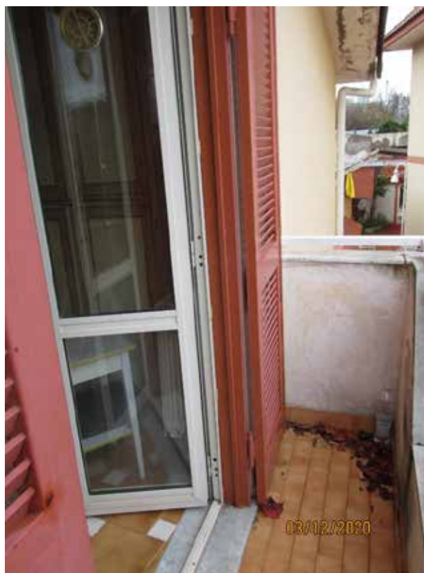
Fotografia 50 – Balcone: Occupa una superficie utile netta pari a mq. 1,72.
