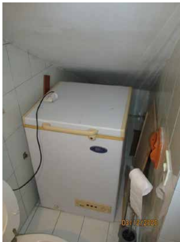
Fotografia 34 – Bagno 1: Il soffitto è rivestito con intonaci ordinari a finitura liscia e tinteggiato con pittura a tempera. Il Bagno è privo di finestra per il riciclo dell’aria.
