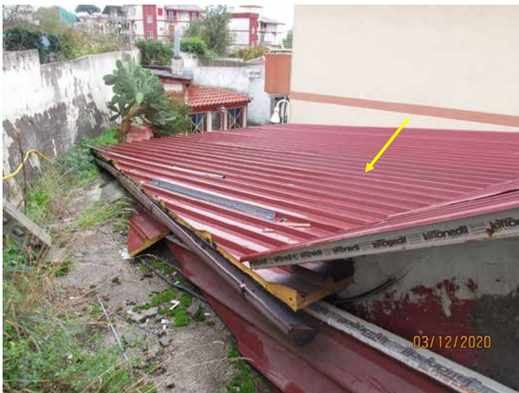
Fotografia 22 – La parte di fabbricato che si eleva per un solo livello fuori terra presenta invece un solaio di copertura ad una sola falda inclinata rivestito da una struttura di pannelli coibentati in lamiere metalliche grecate coibentati.
