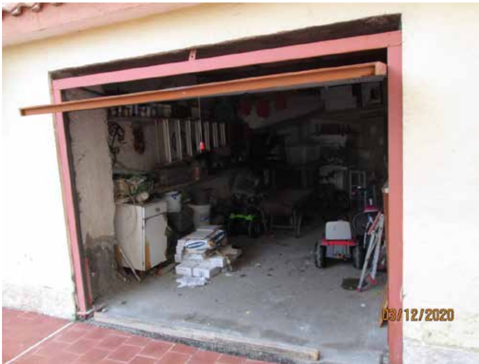
Fotografia 55 – Box auto: Vi si accede dal cortile comune tramite un varco carrabile munito di un serramento in ferro di tipo “basculante”, occupa una superficie utile netta pari a mq. 17,50 e un’altezza dal piano di calpestio pari a ml. 2,35.
