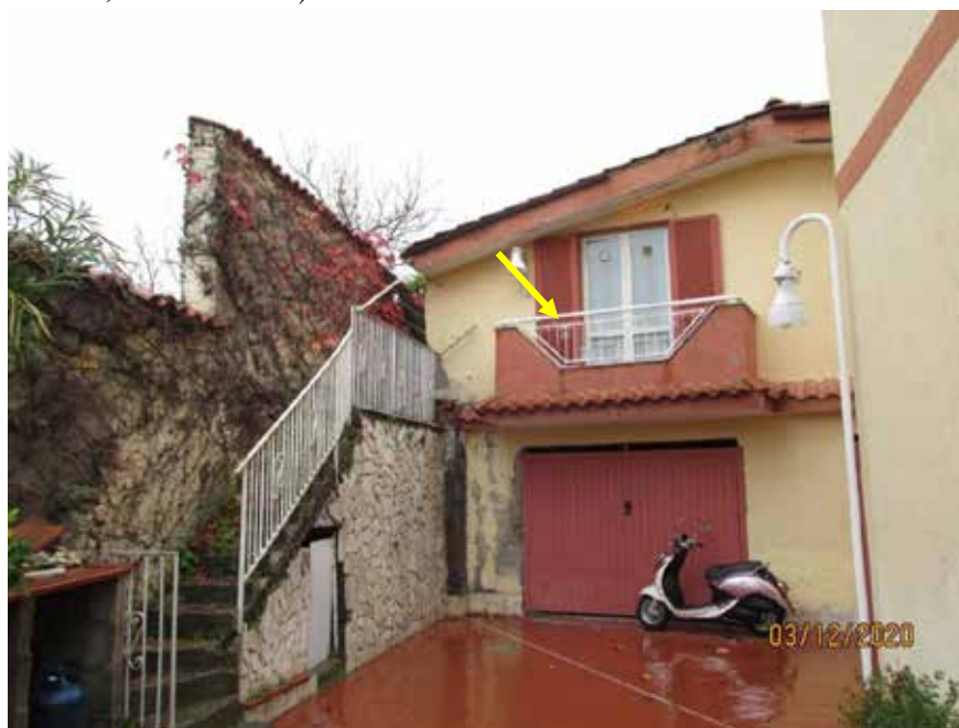
Fotografia 49 – Balcone: Vi si accede dal “Vano 2” è esposto sulla facciata est del fabbricato pignorato e prospetta sul cortile comune.
