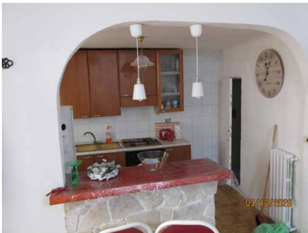
Fotografia 30 – Cucina : La pavimentazione dell’intero ambiente è costituita da piastrelle ceramica smaltata; le pareti sono rivestite con piastrelle in ceramica smaltata ad eccezione di quella confinante con il “Bagno 1” che risulta rivestita con intonaci ordinari e tinteggiata con pittura lavabile; il soffitto del solaio risulta rivestito da intonaci ordinari e tinteggiato con pittura a tempera.
