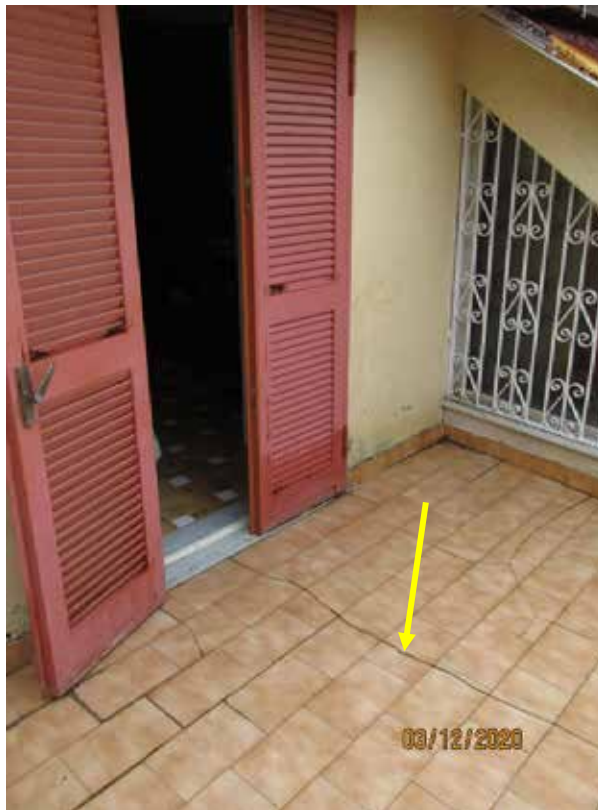
Fotografia 45 – Terrazzino: Sulla pavimentazione sono presenti alcuni segni di lesione, che però non destano preoccupazione e/o segni di cedimento strutturale, probabilmente sono dovute alla vetustà del pavimento e alla scarsa resistenza alle sollecitazioni di dilatazione termica, a cui la piastrella è sottoposto nel periodo sia invernale sia estivo.
