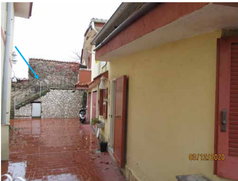
Fotografia 14 – L'area cortilizia, interposta tra i due corpi di fabbrica oltre a condurre agli immobili staggiati ( appartamento sub 4, locale box auto sub 3 e al locale deposito sub 2 ), si collega alla restante area cortilizia comune e ad una scala esterna in muratura che consente l'accesso all'estradosso terrapieno su cui è addossato il fabbricatino pignorato poiché il livello di imposta della struttura è sottoposto ai lotti di terreno circostanti.
