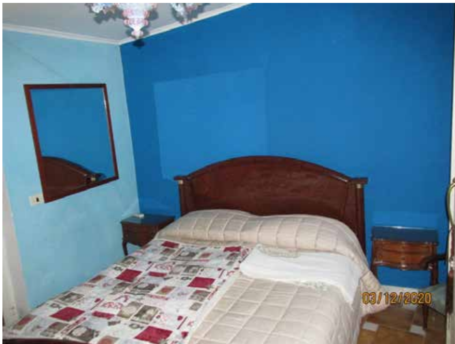
Fotografia 41 – Vano 1: La pavimentazione è costituita per tutta la superficie da piastrelle in ceramica smaltata; le pareti sono rivestite con intonaci ordinari a finitura liscia e tinteggiate con pittura lavabile; il soffitto del solaio è rivestito con intonaci ordinari e tinteggiato con pittura a tempera.
