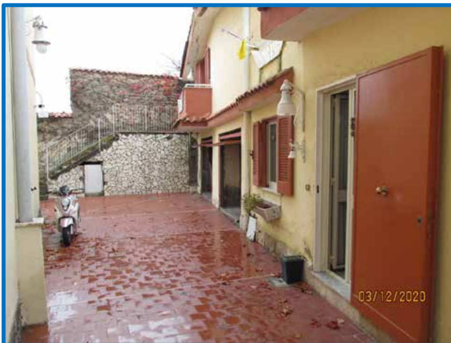
Via Arena San Vito n. 4 -ERCOLANO (NA)-
