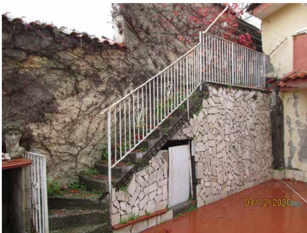
Fotografia 20 – Il terrapieno è accessibile tramite una scala esterna in muratura, munita di ringhiera in ferro, posta sul confine nord del cortile comune.
