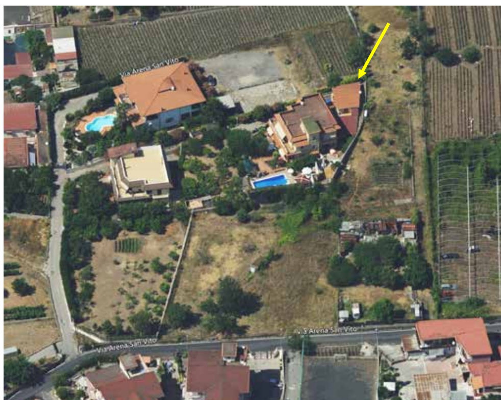
Fotografia 2 – Inquadramento territoriale lato Sud.
