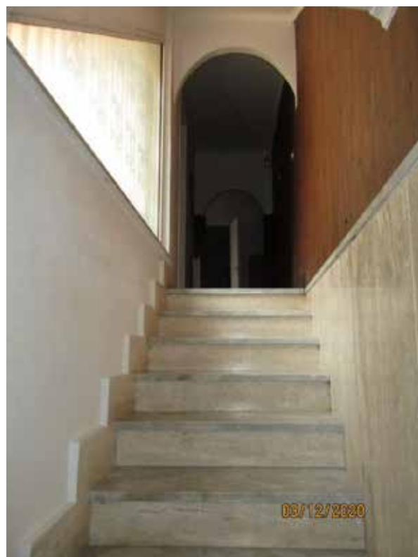
Fotografia 37 – Scala interna : La parete posta a sinistra di chi sale le scale risulta rivestita da intonaci ordinari e tinteggiata con pittura lavabile. Su quest'ultima parete è presente una sfinestratura che prende luce dal "Terrazzino esterno" del primo piano. La finestra è munita di un infisso in alluminio e vetro camera senza apertura ed è protetta dall'esterno con una grata in ferro.
