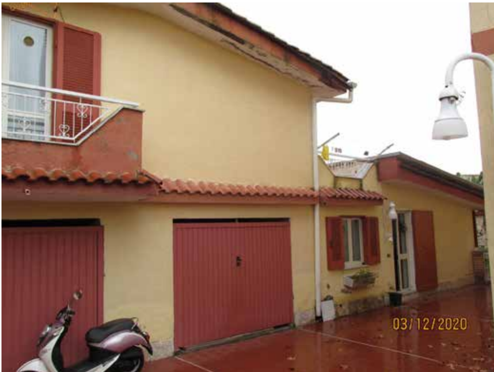
Fotografia 16 – Prospetto esterno libero esposto ad ovest.
