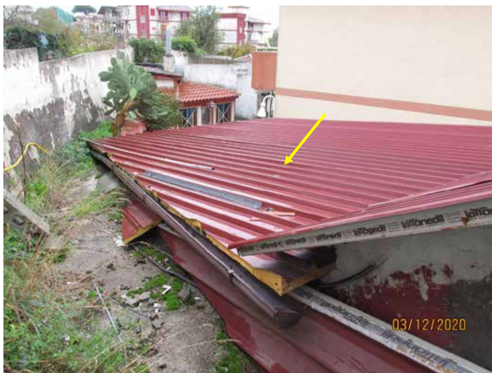
Fotografia 22 – La parte di fabbricato che si eleva per un solo livello fuori terra presenta invece un solaio di copertura ad una sola falda inclinata rivestito da una struttura di pannelli coibentati in lamiera metalliche grecate coibentati.
