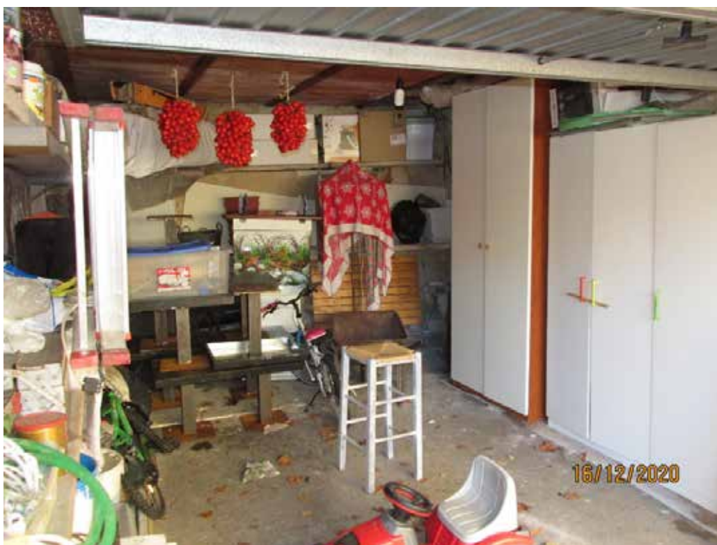
Fotografia 56 – Box auto: La pavimentazione è costituita da un getto in cls; le pareti sono rifinite con intonaci ordinari a finitura rustica; il soffitto del solaio si presenta allo stato grezzo con l'orditura del solaio a vista.
