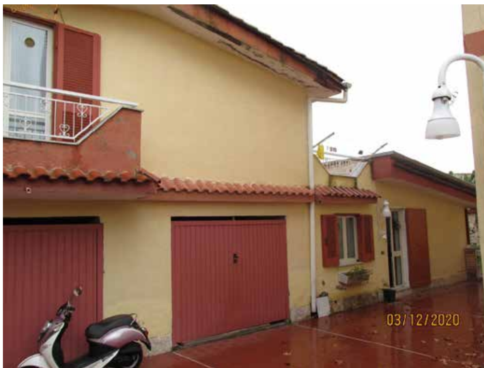
Fotografia 16 – Prospetto esterno libero esposto ad ovest.
