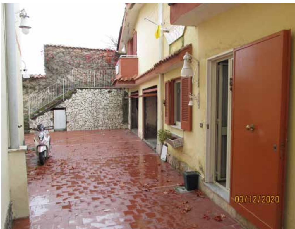
Fotografia 24 – Gli infissi esterni dell’appartamento sono costituiti da serramenti in ferro di tipo “persiane alla napoletana” con retrofinestre in alluminio e vetro camera, mentre il portoncino d’ingresso è dotato di portoncino blindato e di retroinfisso in alluminio e vetro camera; il locale deposito ed il locale box, sono invece dotati all’ingresso da serramenti di tipo “basculanti” in ferro.
