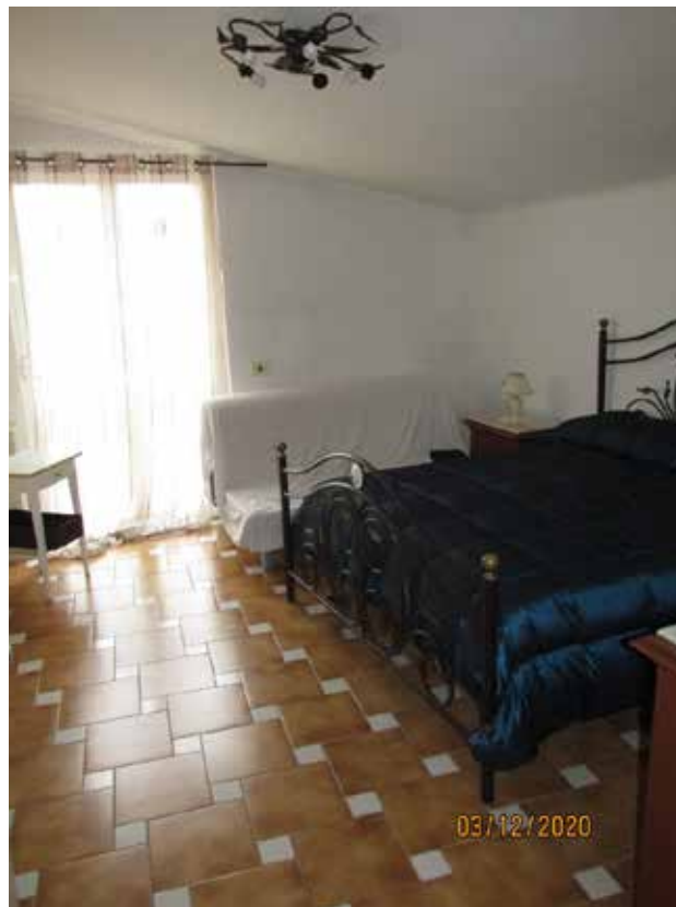
Fotografia 47 – Vano 2: La pavimentazione è costituita per tutta la superficie da piastrelle in ceramica smaltata; la parete nord, lungo il confine con il terrapieno, risulta contro-foderata con elementi di pannellatura in cartongesso, in modo da creare un'intercapedine isolante, la restante parte invece delle pareti, sono rivestite da intonaci ordinari e tinteggiate con pittura lavabile; il soffitto del solaio è rivestito con intonaci ordinari e tinteggiato con pittura a tempera.
