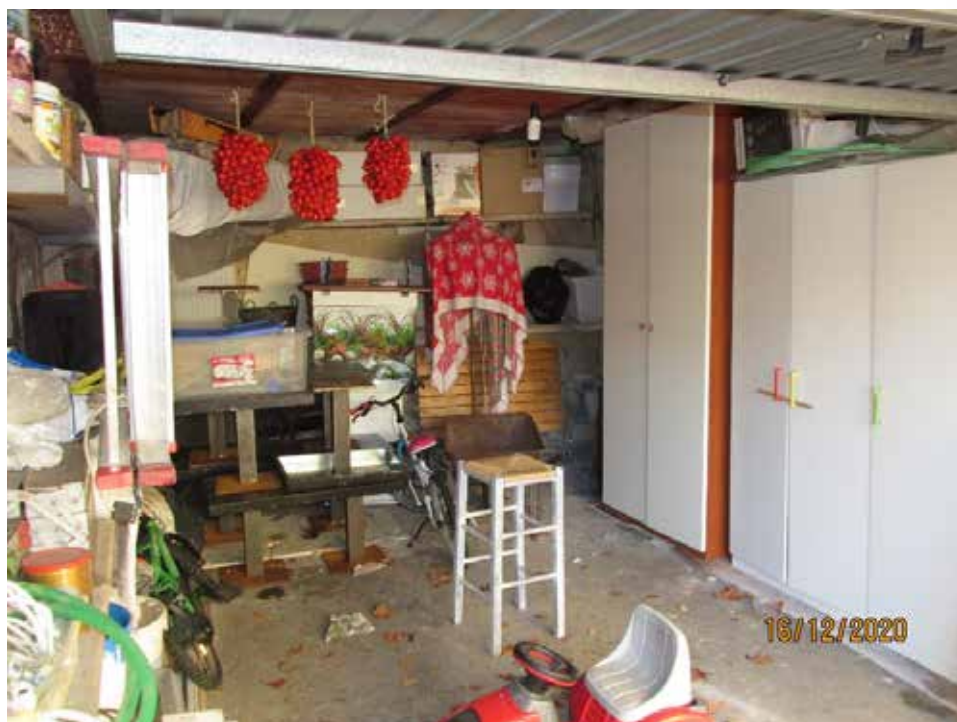
Fotografia 56 – Box auto: La pavimentazione è costituita da un getto in cls; le pareti sono rifinite con intonaci ordinari a finitura rustica; il soffitto del solaio si presenta allo stato grezzo con l’orditura del solaio a vista.
