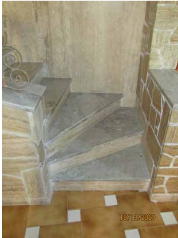
Fotografia 35 – Scala interna: consente il collegamento tra il “Soggiorno/Pranzo” del Piano Terra e il “Corridoio” del Piano Primo. La scala è costituita da un’unica rampa con i gradini interamente rivestiti in marmo.
