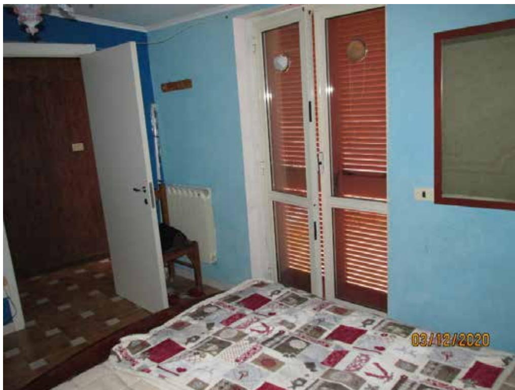
Fotografia 42 – Vano 1: Il vano è dotato di una porta-balcone che immette su un terrazzino annesso all'appartamento con affaccio sul cortile interno, il vano è dotato di infisso in alluminio con vetro camera, protetto all'esterno da un infisso in ferro di tipo “persiana alla napoletana”.
