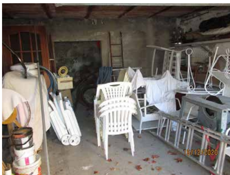
Fotografia 59 – Deposito: La pavimentazione è costituita per tutta la superficie da un getto in cls.
