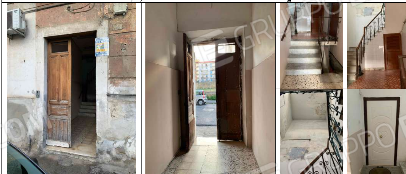
Foto 7, 8, 9, 10, 11, 12: viste androne fabbricato, corpo scala e ingresso appartamento
