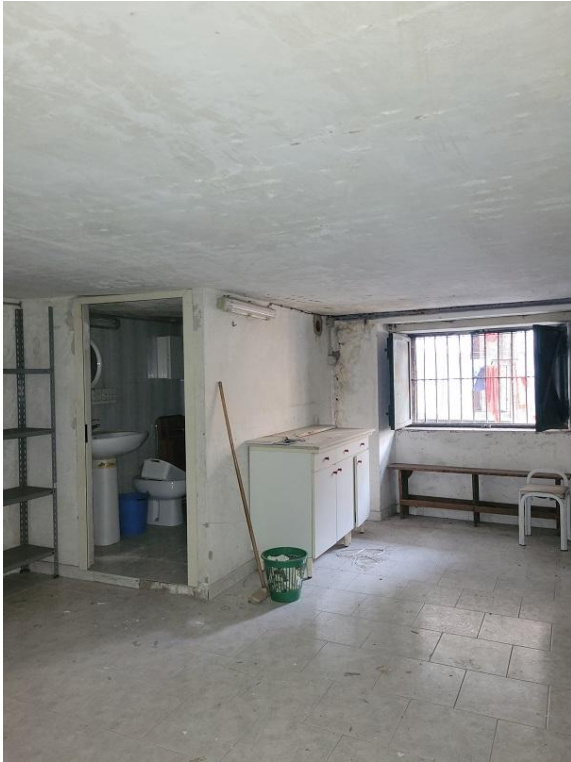
Vista area sopalcata
