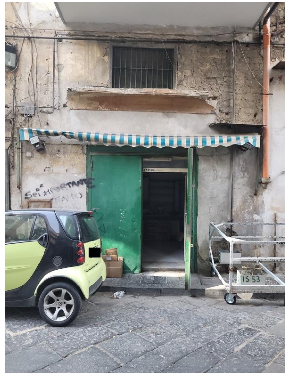
Vista portone di accesso all'immobile
