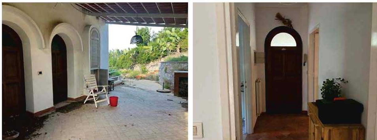
Sulla sinistra, vista esterna delle porte di ingresso; sulla destra, particolare interno di una delle porte
