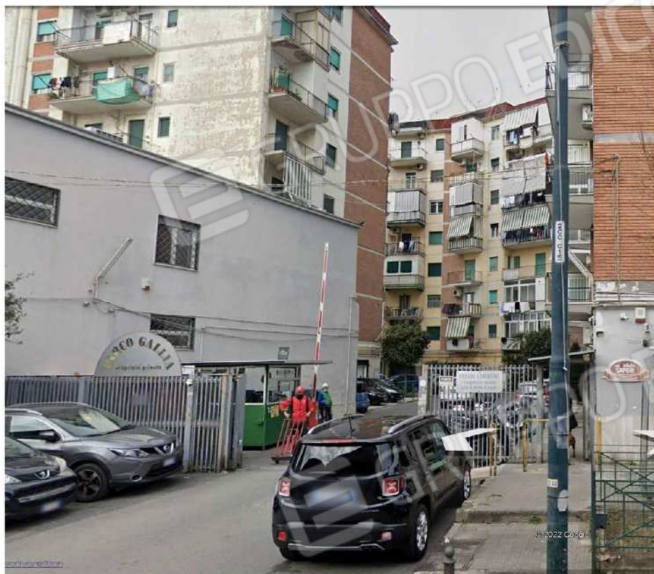
Foto 1 – Complesso residenziale “Parco Gallia” in cui è ubicato l’immobile pignorato
