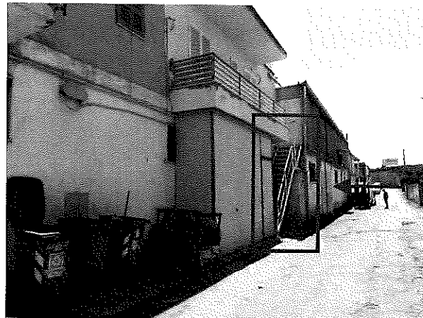
Scala di accesso al P1 e portone d'ingresso al PT
