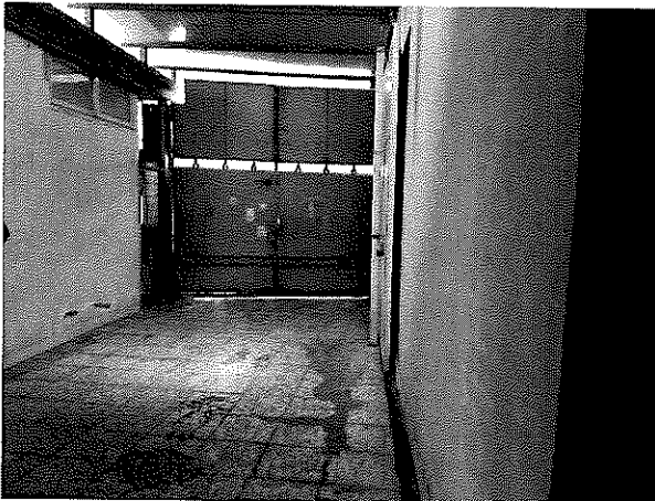
Spazio comune del fabbricato (androne)
