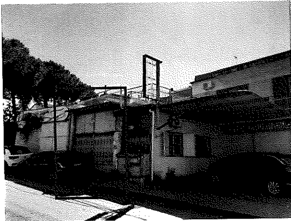
Ingresso fabbricato su Via Sac. G. D'Antonio Servo di Dio
