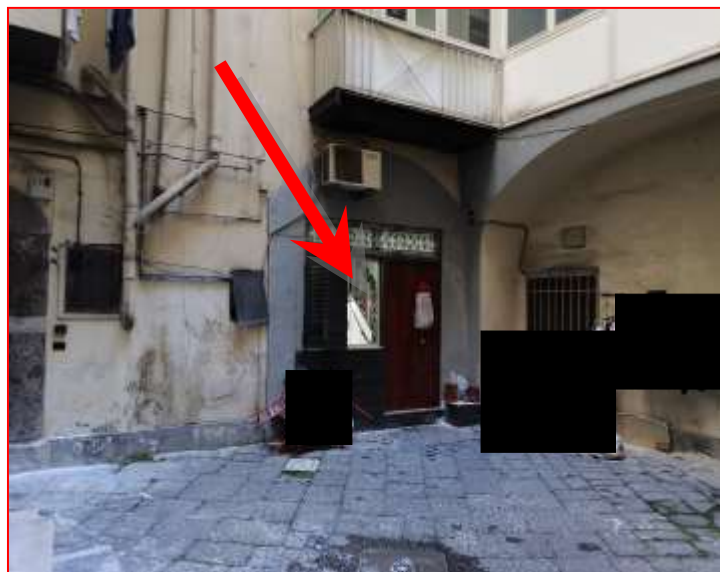
Foto 2: ingresso dell'u.i. staggita dal cortile del palazzo
