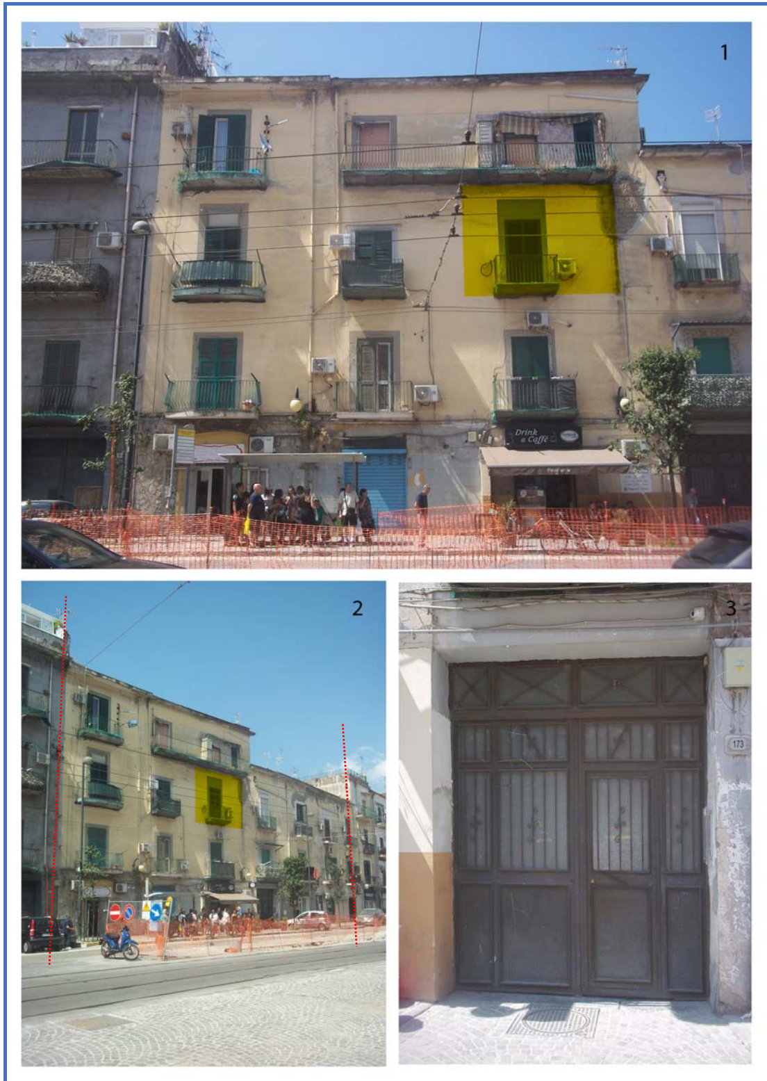
(Foto 1-2 Individuazione del Cespite sul prospetto prospiciente Corso San Giovanni a Teduccio) (Foto 3 Cancello di Accesso civ.n°173 del più ampio Fabbricato nel quale è presente il cespite)
