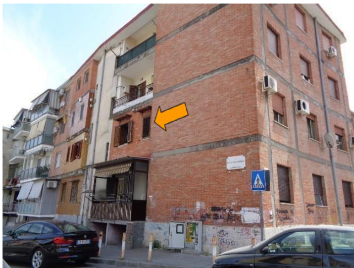
Veduta esterna del fabbricato da Via Monte S. Gabriele
