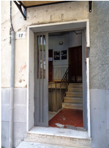
Particolare del portone d'accesso al fabbricato al civ. 17 di Via Monte S. Gabriele
