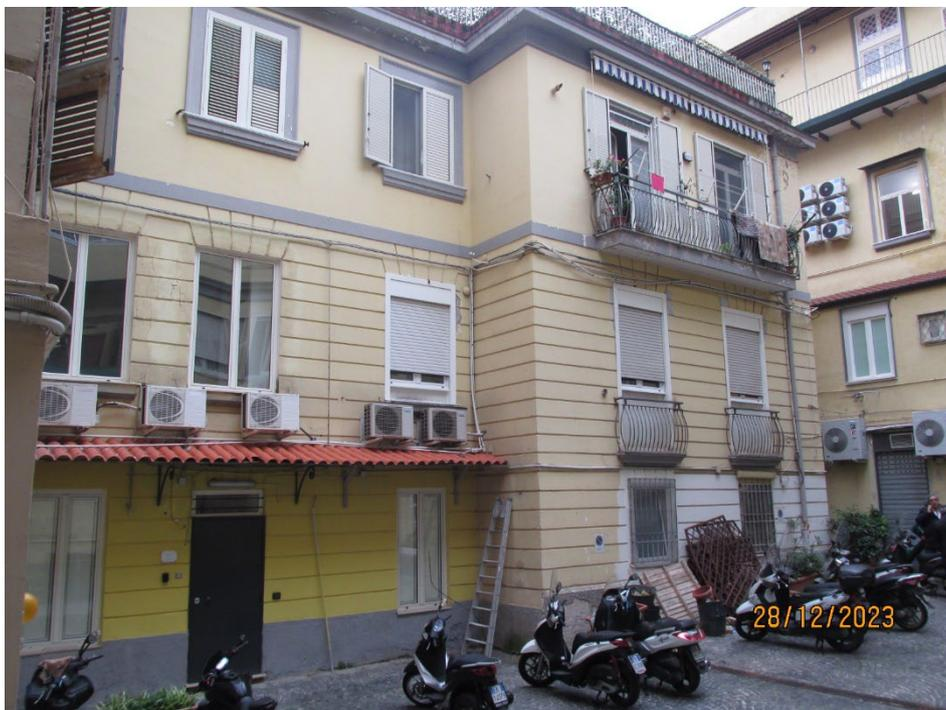
Fotografia 14 – I prospetti del fabbricato che affacciano nel cortile comune presentano le pareti rivestite da intonaci ordinari a finitura liscia e tinteggiate con pittura al quarzo, le balconate risultano costituite da lastre in marmo a sbalzo, ancorate alle pareti con mensole in ferro di sostegno.
