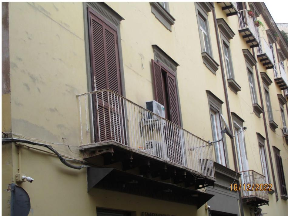
**Fotografia 29 – Balconata:** La struttura è costituita da un unico blocco a spessore di marmo bianco, incastrato alla parete verticale della facciata del fabbricato rinforzato nella parte inferiore da mensole in ferro di sostegno incastrate alla parte. La balconata è protetta lungo l’aggetto da una rischiera in ferro.
