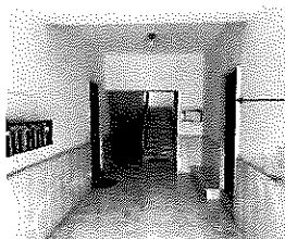
Foto 3 - Androne di fabbricato
