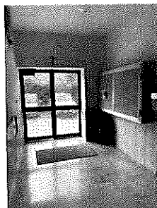
Foto 4 - Androne di fabbricato
