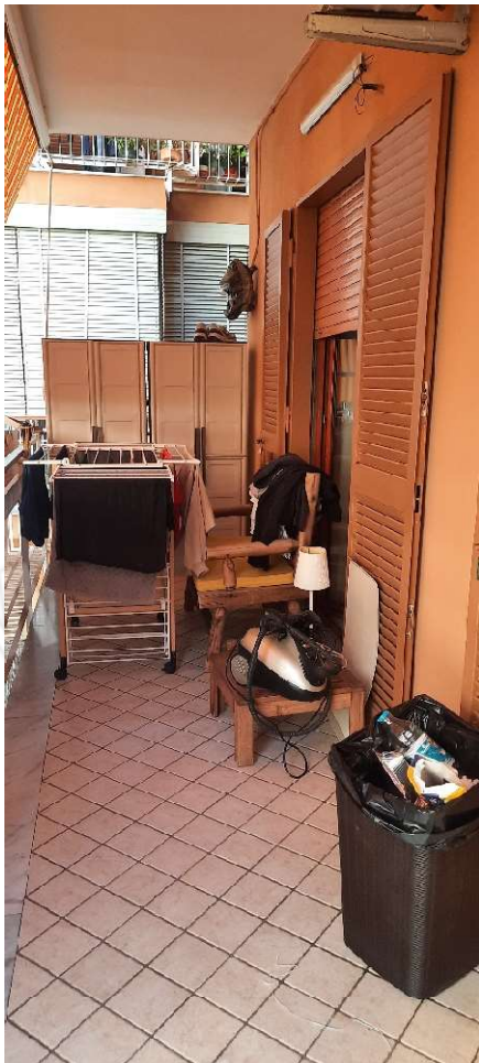
Foto n. 7 _ Particolare di una balconata dell'immobile esaminato
