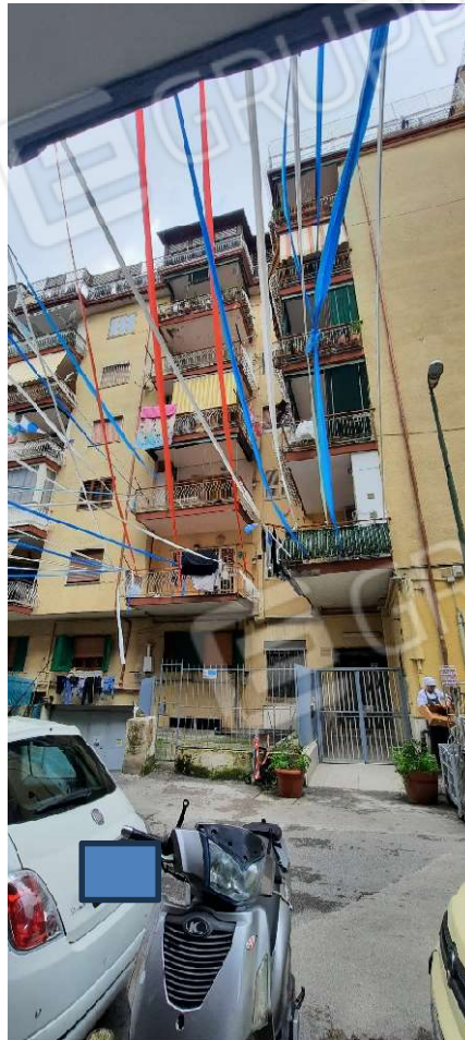
Foto n. 1 _ fabbricato in Napoli alla via F Arnaldi 48
