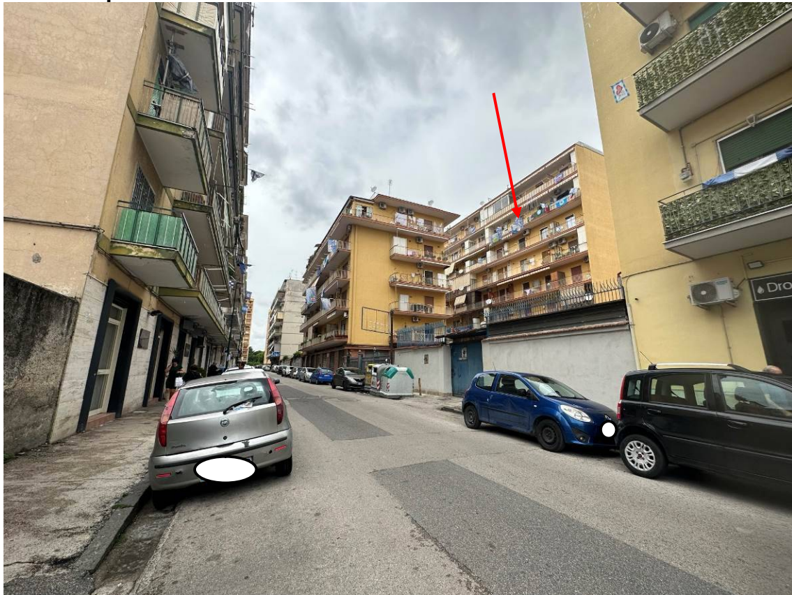
Foto 01 – La via Trentino e individuazione del fabbricato scala B
