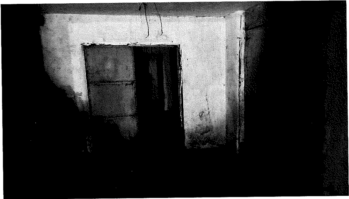
Accesso al cespite
