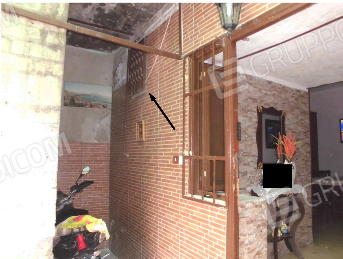
Foto n. 38: • Intercapedine antistante alla facciata d'ingresso. • Il finestrino evidenziato è quello del bagno.
