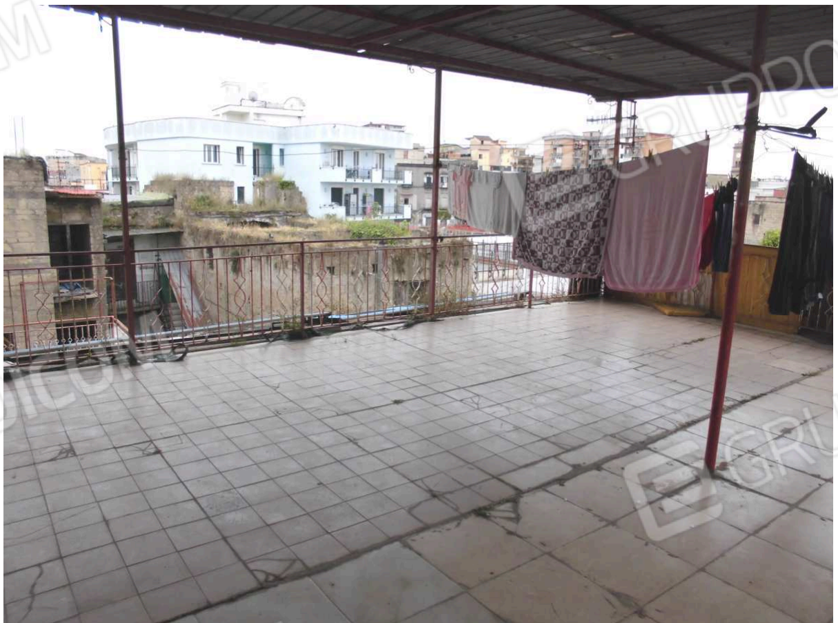
Foto n. 36: • Lastrico solare del corpo di fabbrica insistente sulla particella 40.
