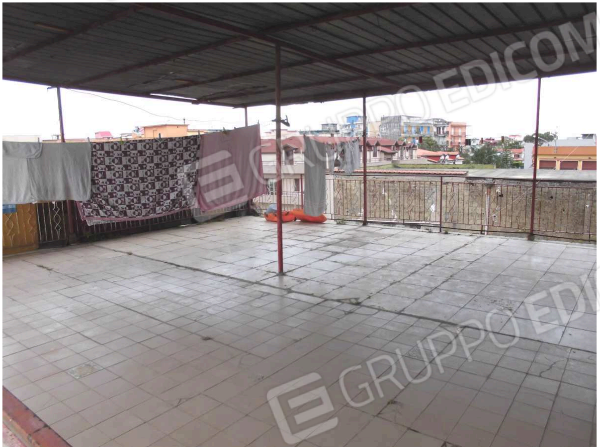
Foto n. 35: • Lastrico solare del corpo di fabbrica insistente sulla particella 40.
