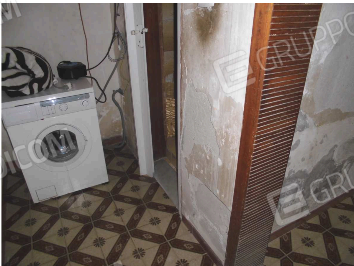
Foto n. 14: • Altro particolare della foto n. 12.
