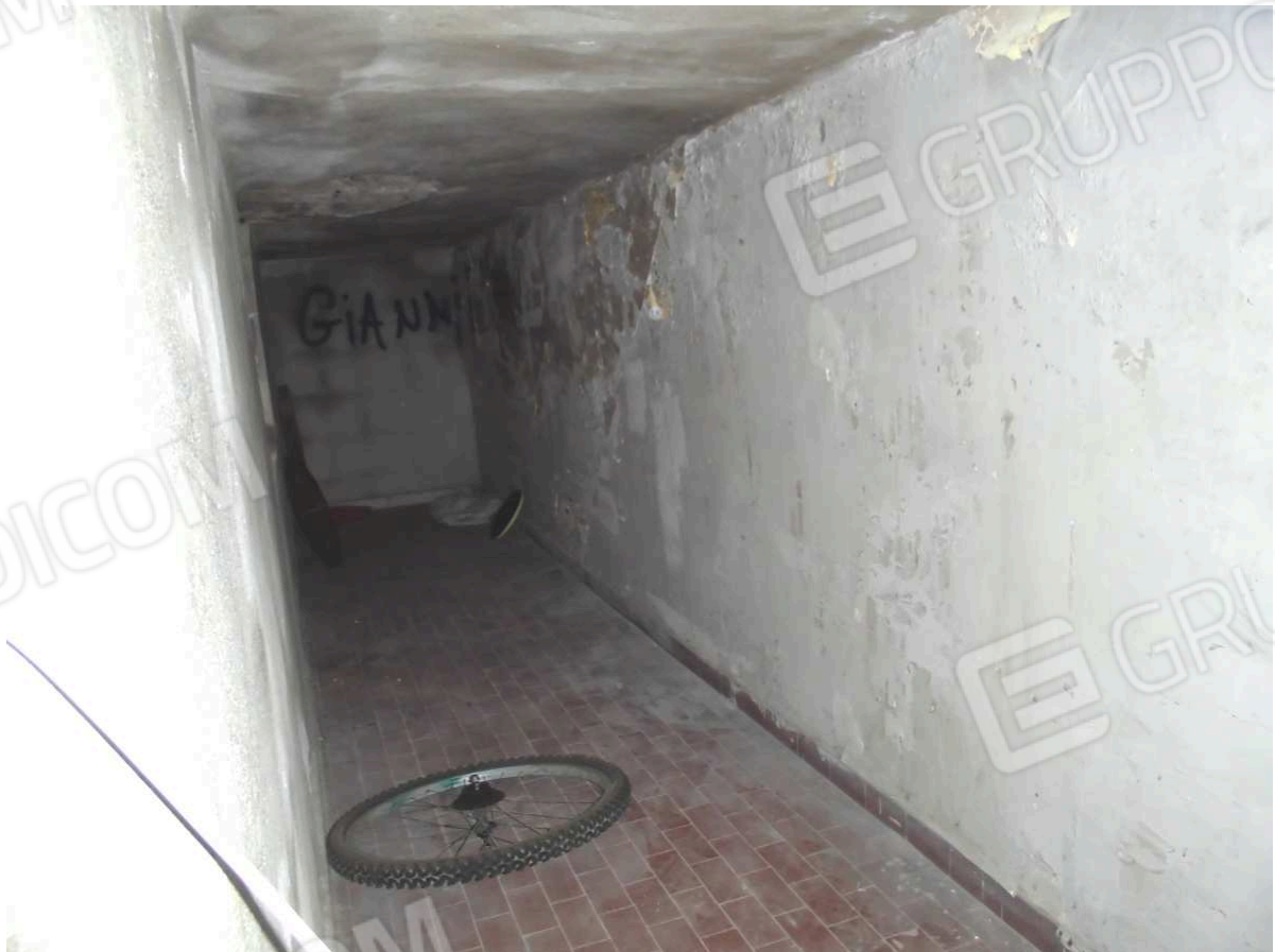
Foto n. 34: • Interni del mezzanino (si notino le condizioni dei paramenti).
