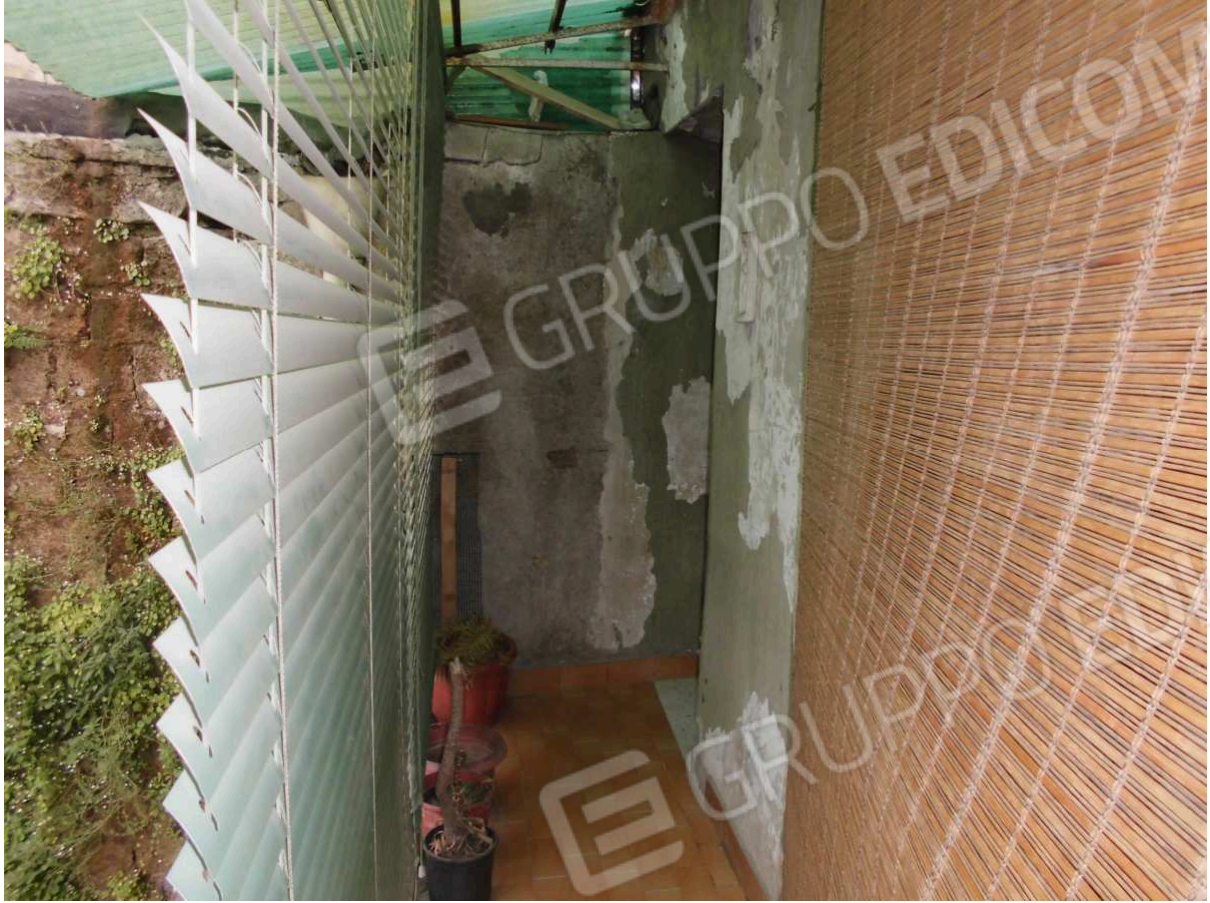
Foto n. 23: • Balcone dell'appartamento al primo piano (lato spiazzo di accesso al caseggiato).
