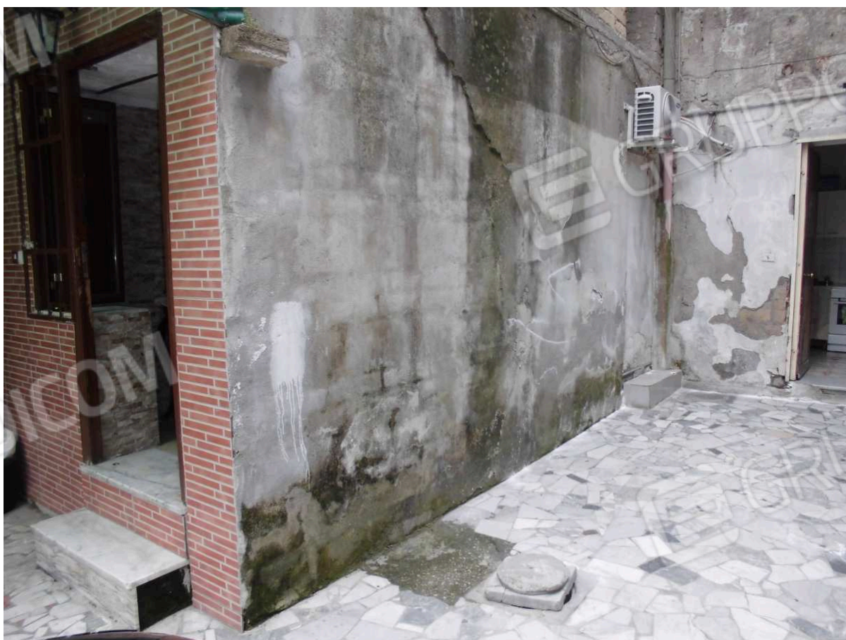
Foto n. 47: • Parete laterale. • Le macchie alla base del paramento testimoniano il problema dell'umidità da risalita.
