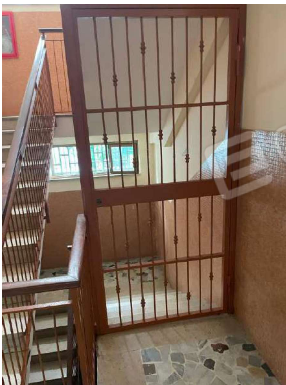
Foto 22_ INGRESSO AL PIANO -I ALLE CANTINE
