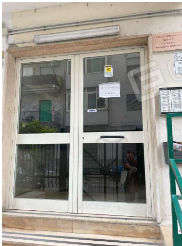
Foto 6_ INGRESSO AL FABBRICATO
