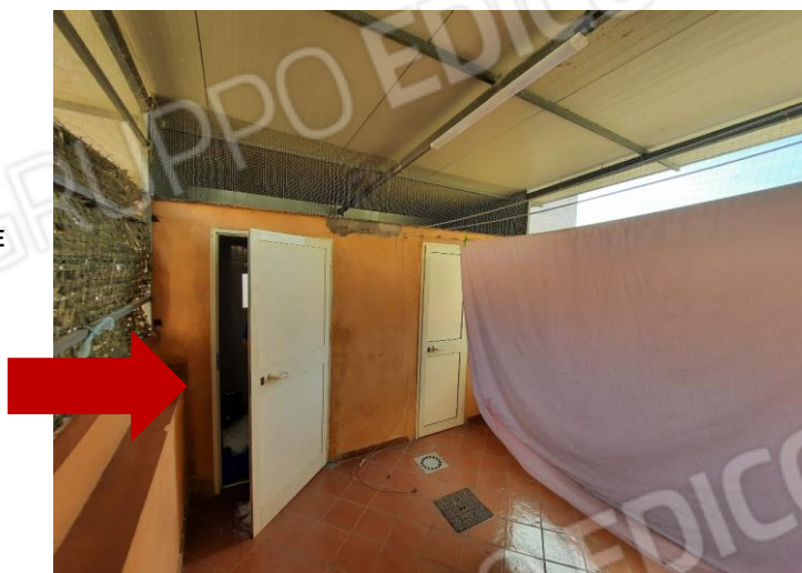
FOTO 25-28 VISTE DEL TERRAZZO COPERTO COMUNE AL COMPENDIO PIGNORATO ED AL SUB 8. GLI INTERNI DEL LOCALE DEPOSITO-LAVANDERIA, POSTO A SINISTRA.
