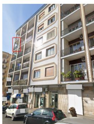
Foto n. 2 - Fabbricato in cui è ubicato l'immobile pignorato
