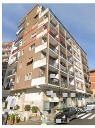
Foto n. 1 - Fabbricato in cui è ubicato l'immobile pignorato
