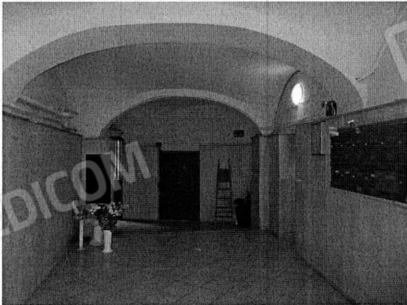
Foto n.3/5: Napoli, via ponte di Casanova n.49. Ingresso fabbricato e interno androne, particolari.
