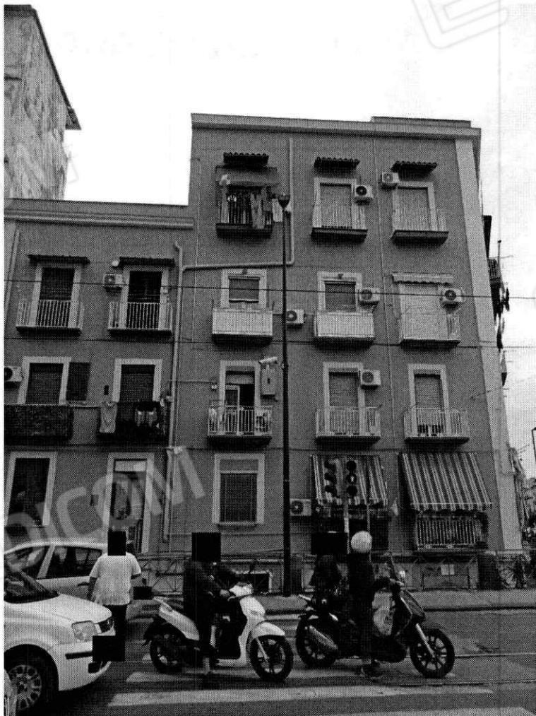
Foto n.1/2: Napoli, via ponte di Casanova n.49. Esterno del fabbricato, particolare
