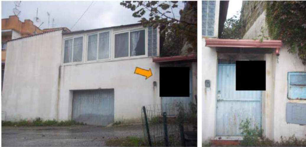
Veduta esterna del fabbricato da Coste Sant'Angelo civico n°50
