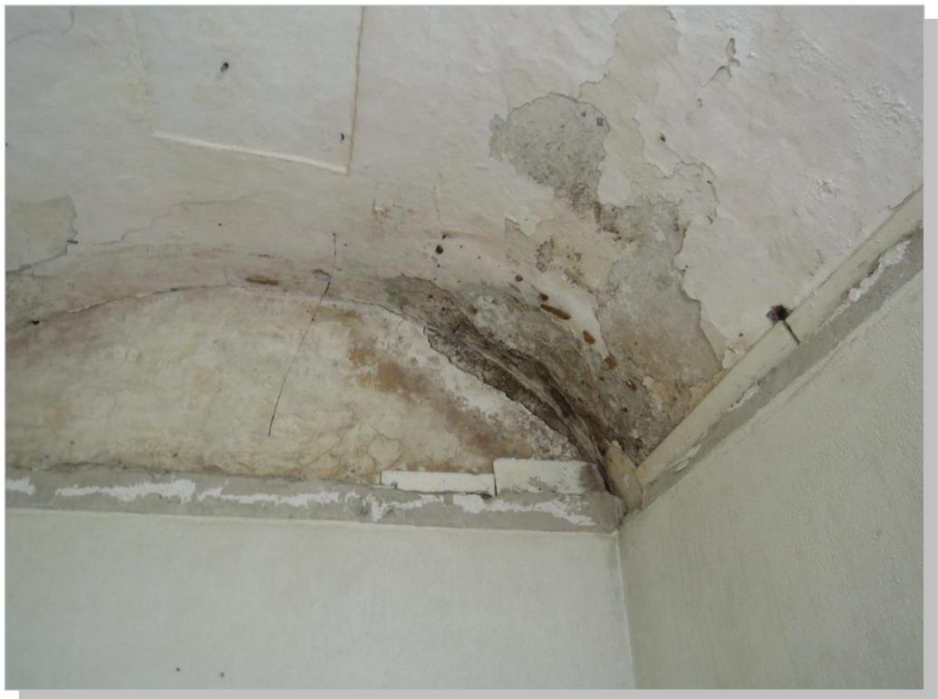
Altre foto rappresentanti il diffuso fenomeno infiltrativo sui soffitti con la presenza di un telone in plastica a copertura del soffitto della cucina.
