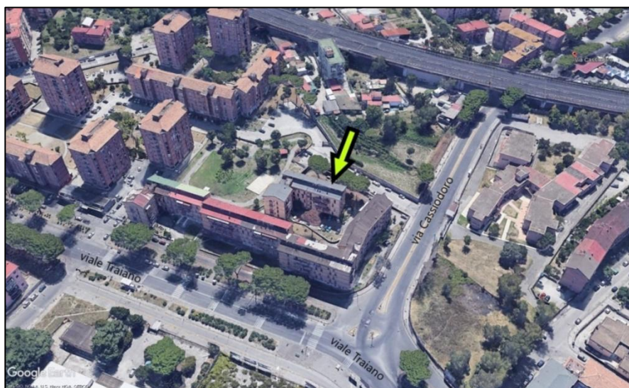
Figura 3 Particolare del fabbricato
