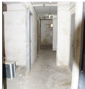
Corridoio di accesso alle cantinole
