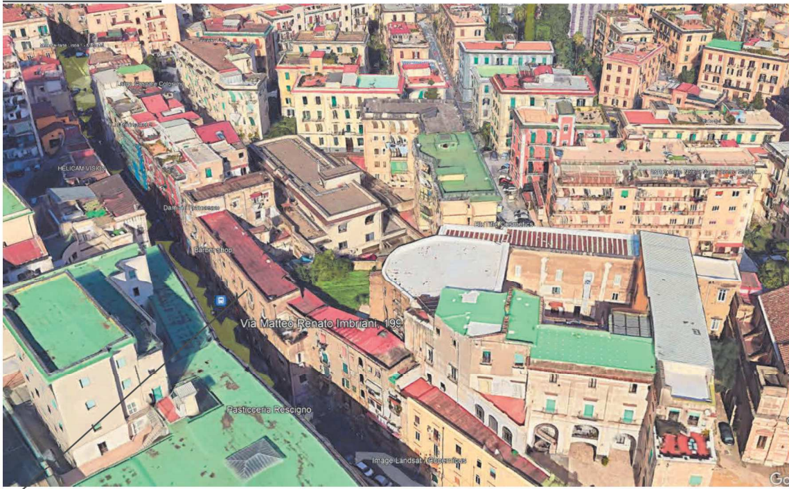
Fabbricato di cui è parte l'immobile pignorato – Napoli via Matteo Renato Imbriani, 199
