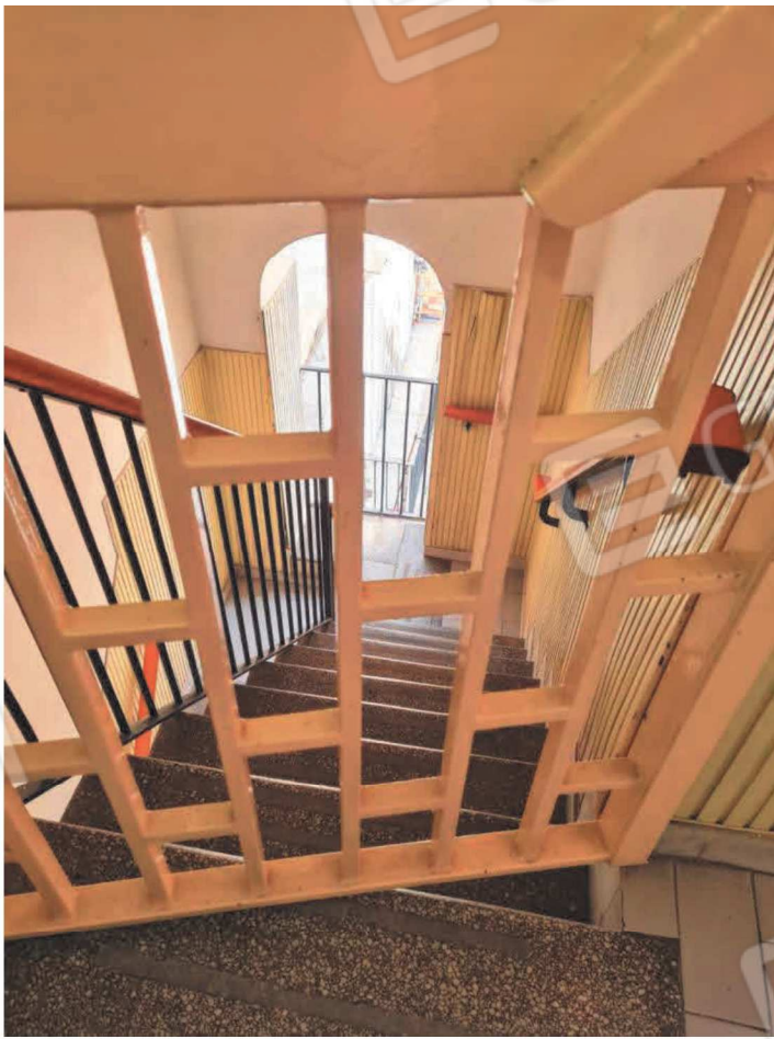
Scala di accesso
