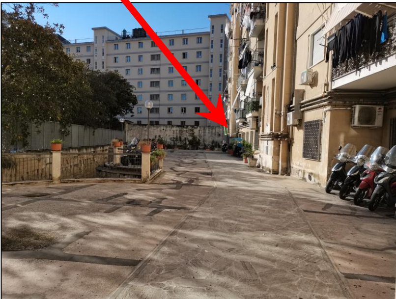
Foto 5: vista del Cortile. La freccia indica la posizione del portone d'ingresso della scala "A".
