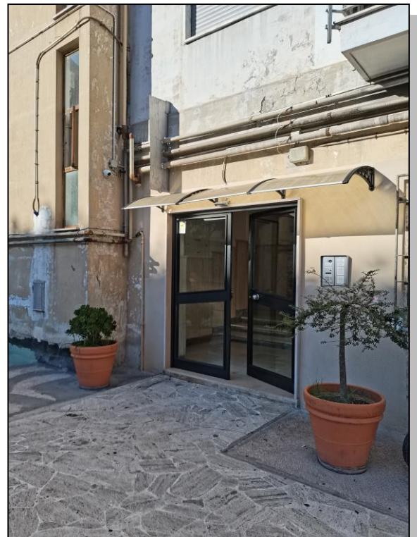
Foto 6: Portone d'ingresso della scala "A".
