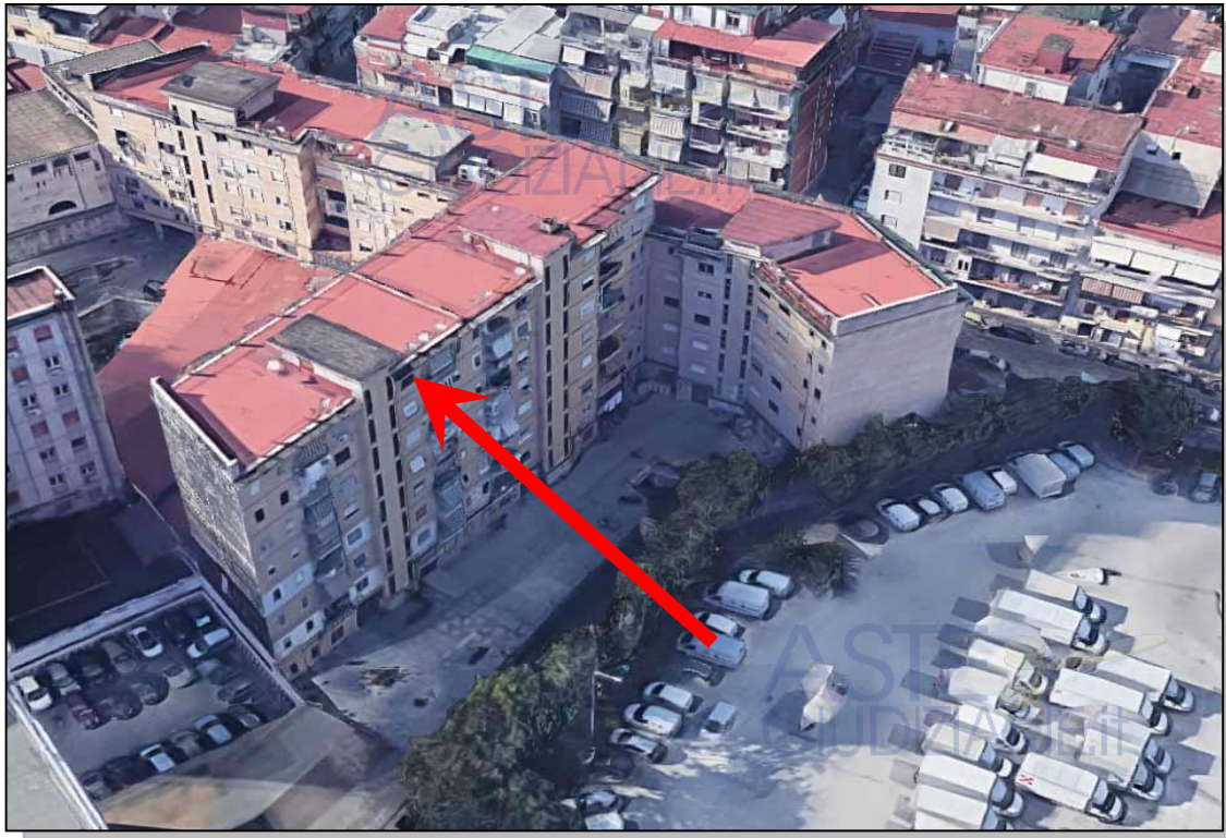
Foto 2-3: Vista complessiva del fabbricato ove è posta l'u.i. staggita.
