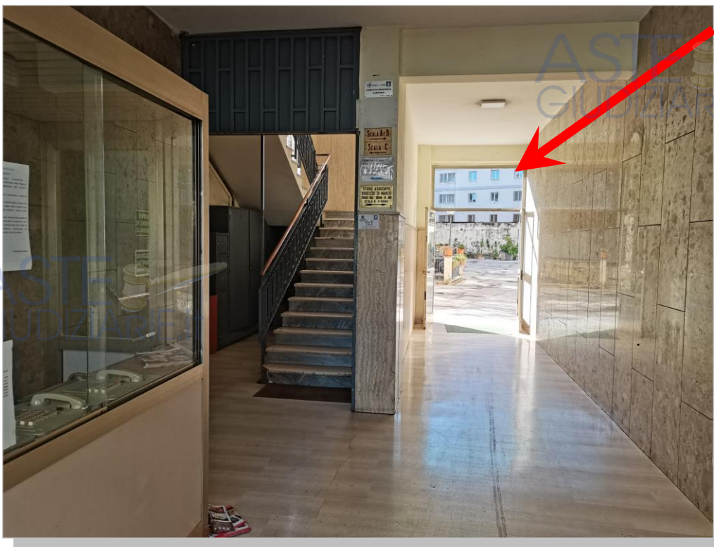
Foto 4: Androne dell'intero complesso immobiliare. In fondo a dx si intravede l'accesso al cortile ove è posizionato il fabbricato "C" – Corpo "C1" Scala "A".
