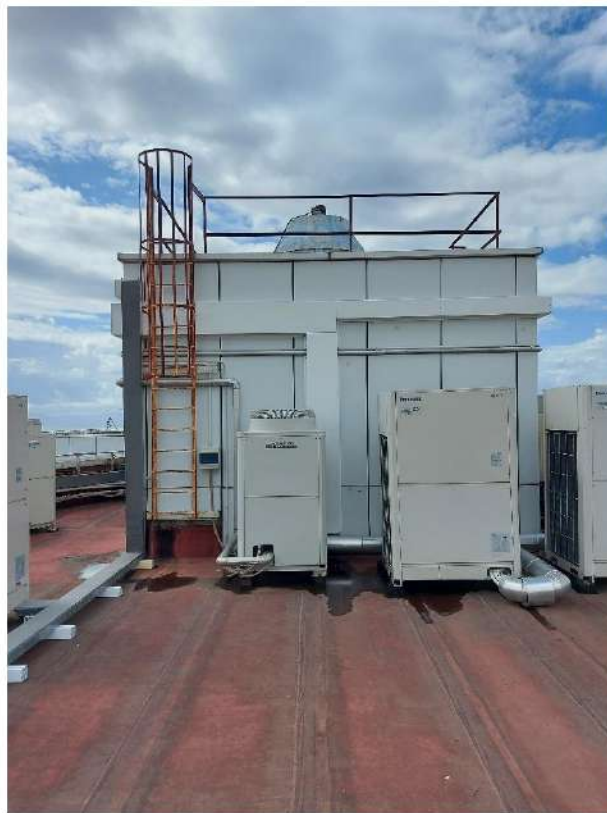
Scala di accesso al lastrico solare bene 4
