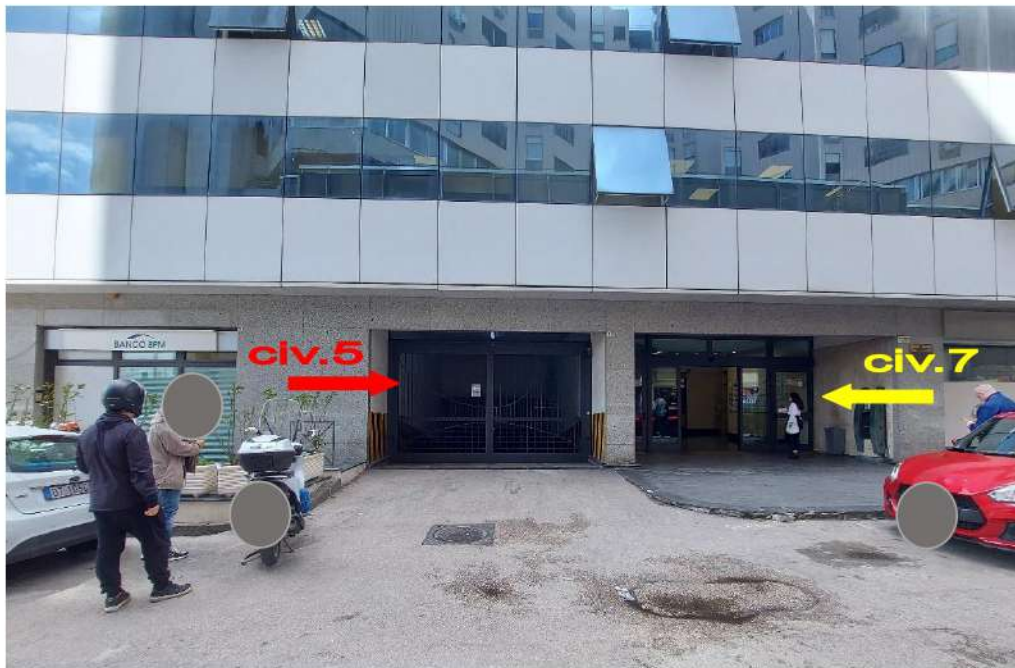
via del Fiumicello- accessi fabbricato: civ. 5 (bene 1,2 e 3) e civ. 7 (bene 4)
