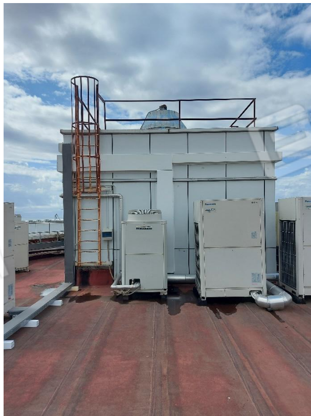
Scala di accesso al lastrico solare bene 4
