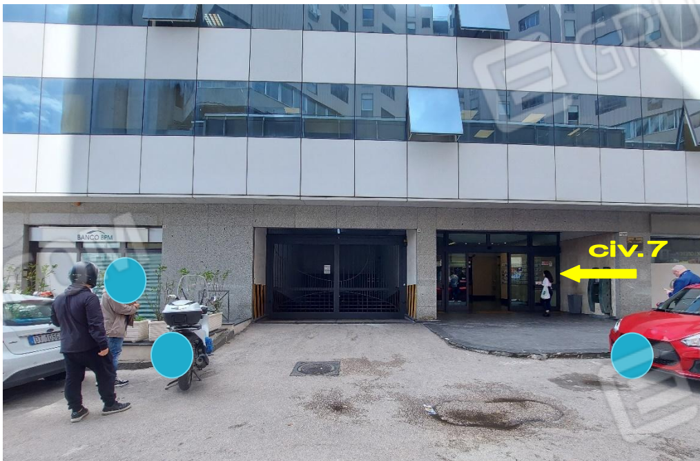
prospetto nord via del Fiumicello- accesso fabbricato civ. 7
