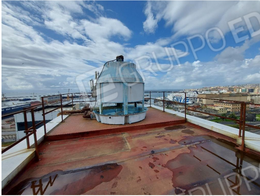
Calpestio lastrico solare bene 4 – manufatto di impianto condominiale (non funzionante)
