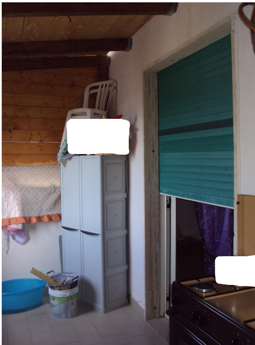
Foto n° 7: interno della veranda
