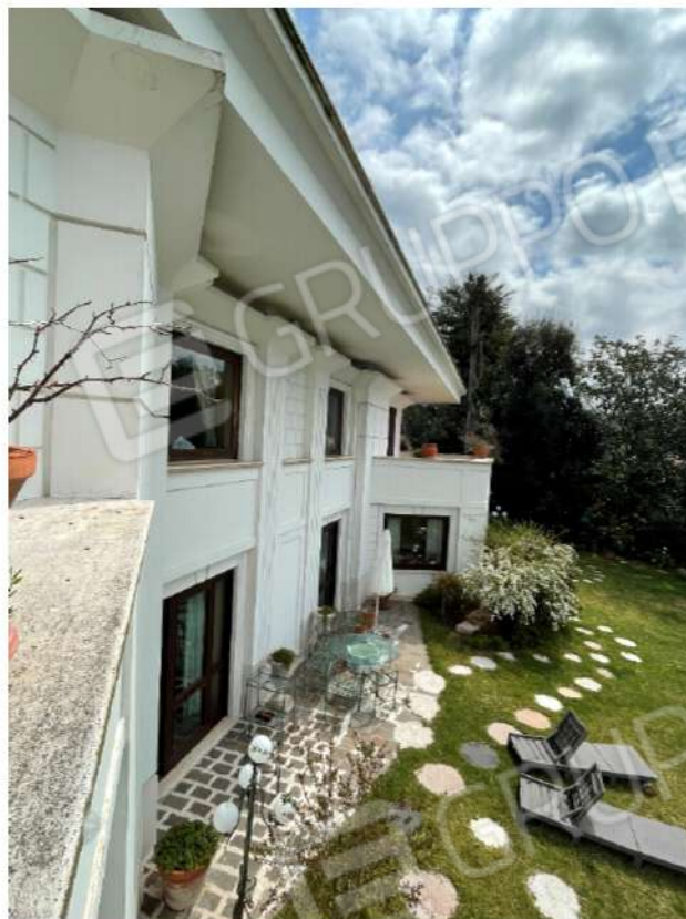
Prospetto su area esterna a sud-ovest
