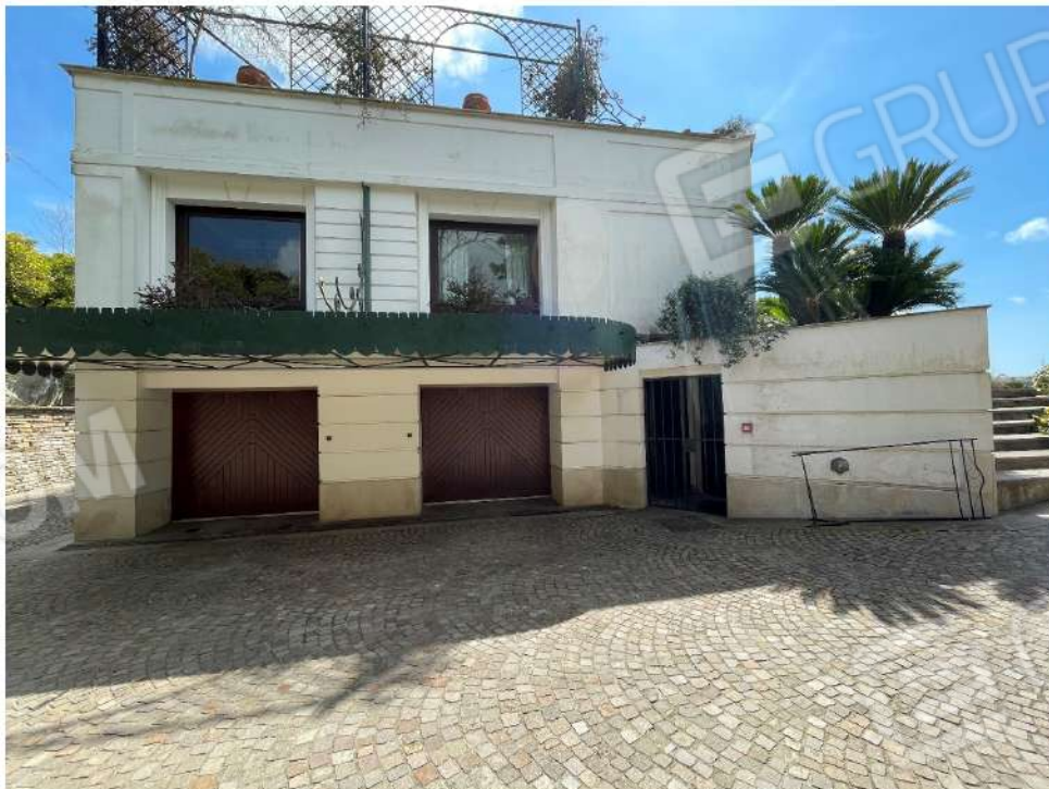
Ingressi al garage sulla facciata nord-ovest
