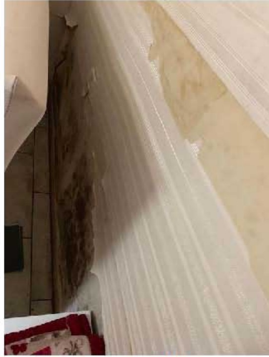
Particolare della principale infiltrazione di umidità alle spalle del letto
