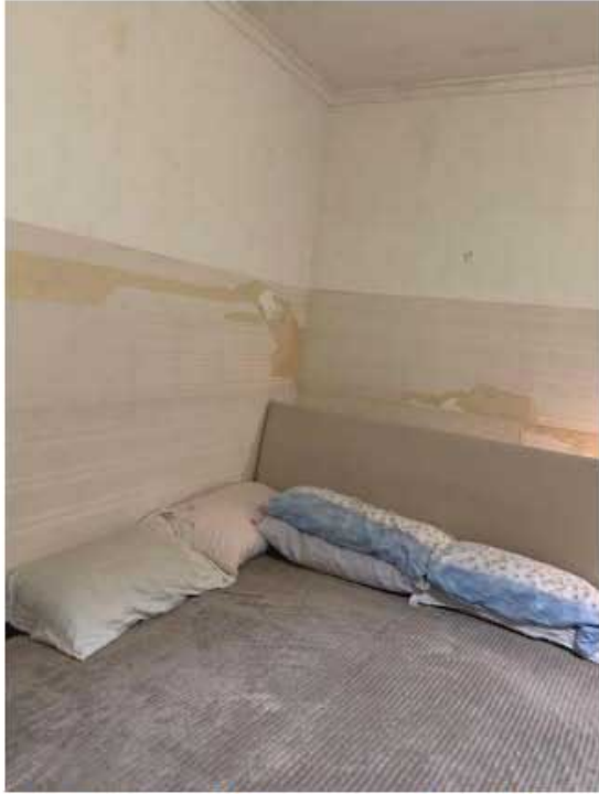
Particolare della principale infiltrazione di umidità alle spalle del letto
