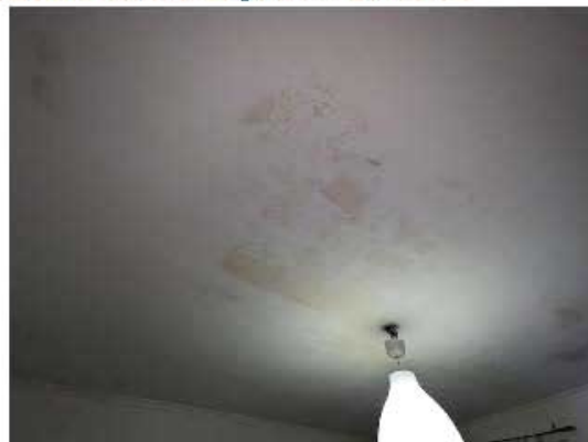
Particolare della principale infiltrazione di umidità alle spalle del letto
