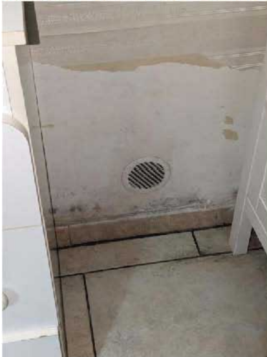
Particolare del sistema di areazione del locale (seminterrato)
