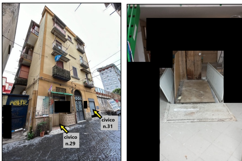
Fig. nn. 3a e 3b. L'ingresso al negozio del civico 28, utilizzato [REDACTED] dal quale si accede al piano sottostrada mediante una botola.
