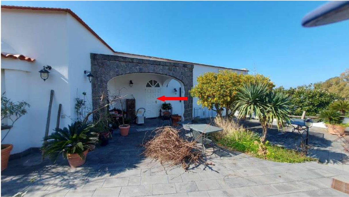
prospetto est - accesso principale al villino
