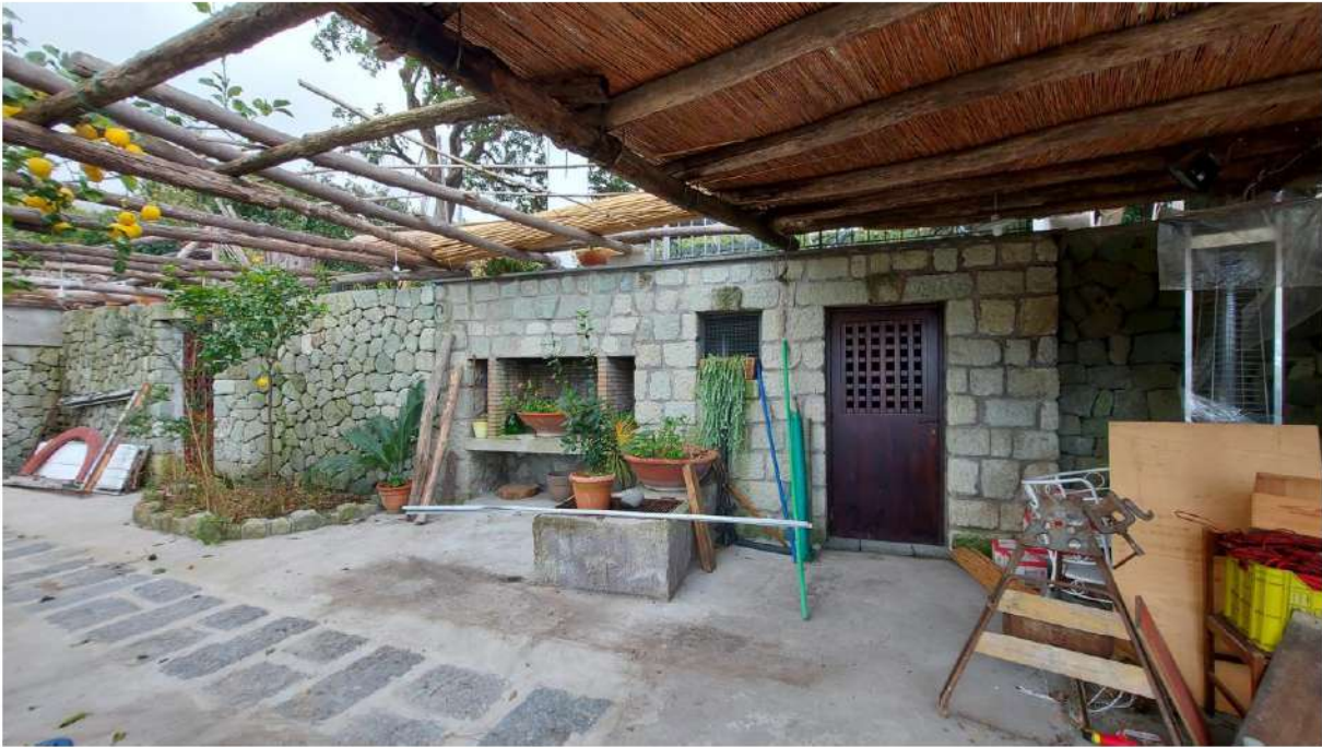
p.lla 1314 - locali tecnici a servizio del ristorante (p.lla 1282 sub.1)
